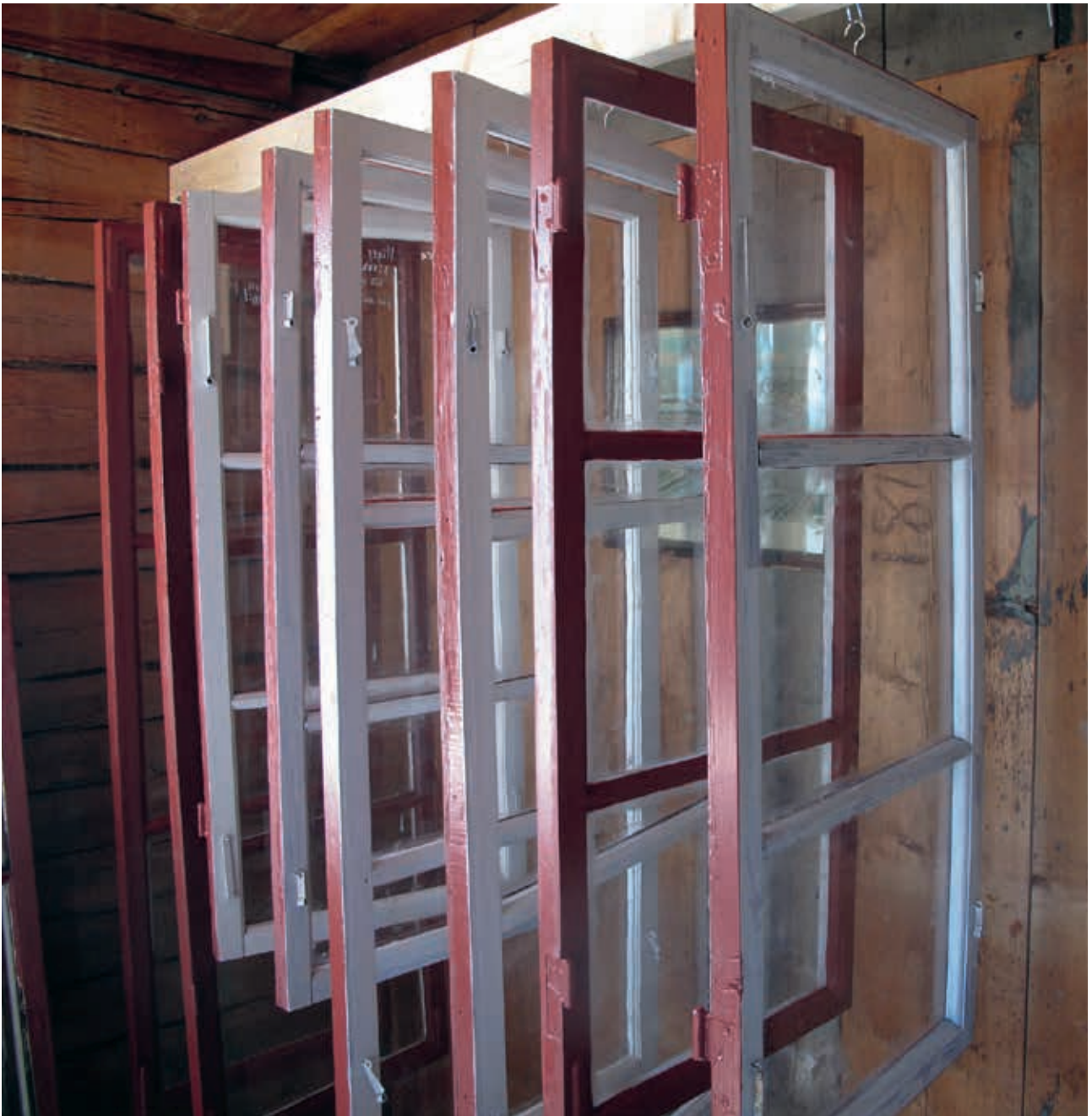
LP 201300780. Renoverade fönster hänger på tork i övervåningen. Fönster nummer tre och fyra närmast i bild är husets äldsta och med största sannolikhet från byggnadens uppförande. Detta syns bl.a. på beslagen. Fönstren är hemmahörande i övervåningen, rakt över verandan. Foto H. Bellberg
