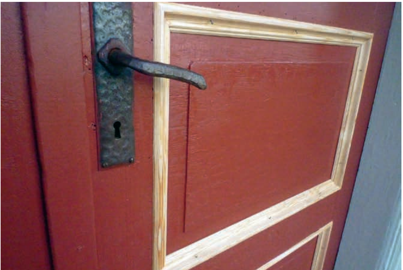
Dörrarnas ytersida mer den nya profilerade fyllningslisten infälld. Foto P.O. Johansson
