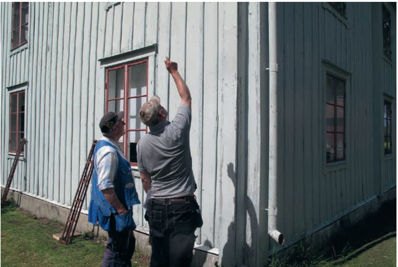
LP 201300774. Bertil från föreningen och Kjell från Roslagens Byggnadsvård vid sydfasaden innan restaureringen. Foto H. Bellberg
