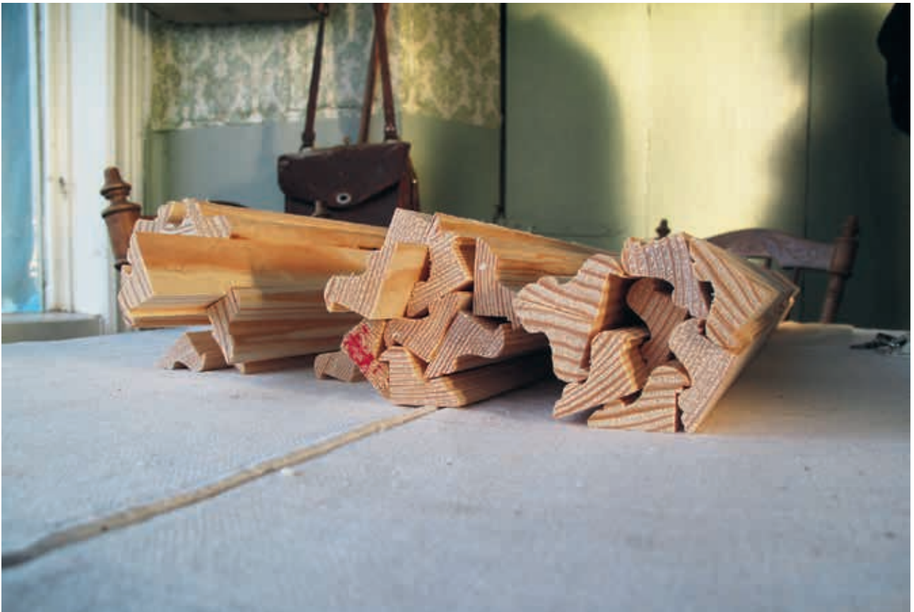
LP 201300788. Ny fyllningslist till dörrspeglarna. Foto H. Bellberg
