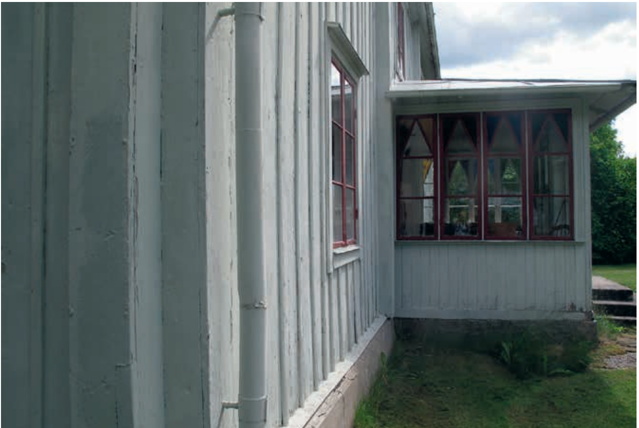
LP 201300773. Verandan på västsidan innan fönsterrestaurering och ommålning. Foto H. Bellberg
