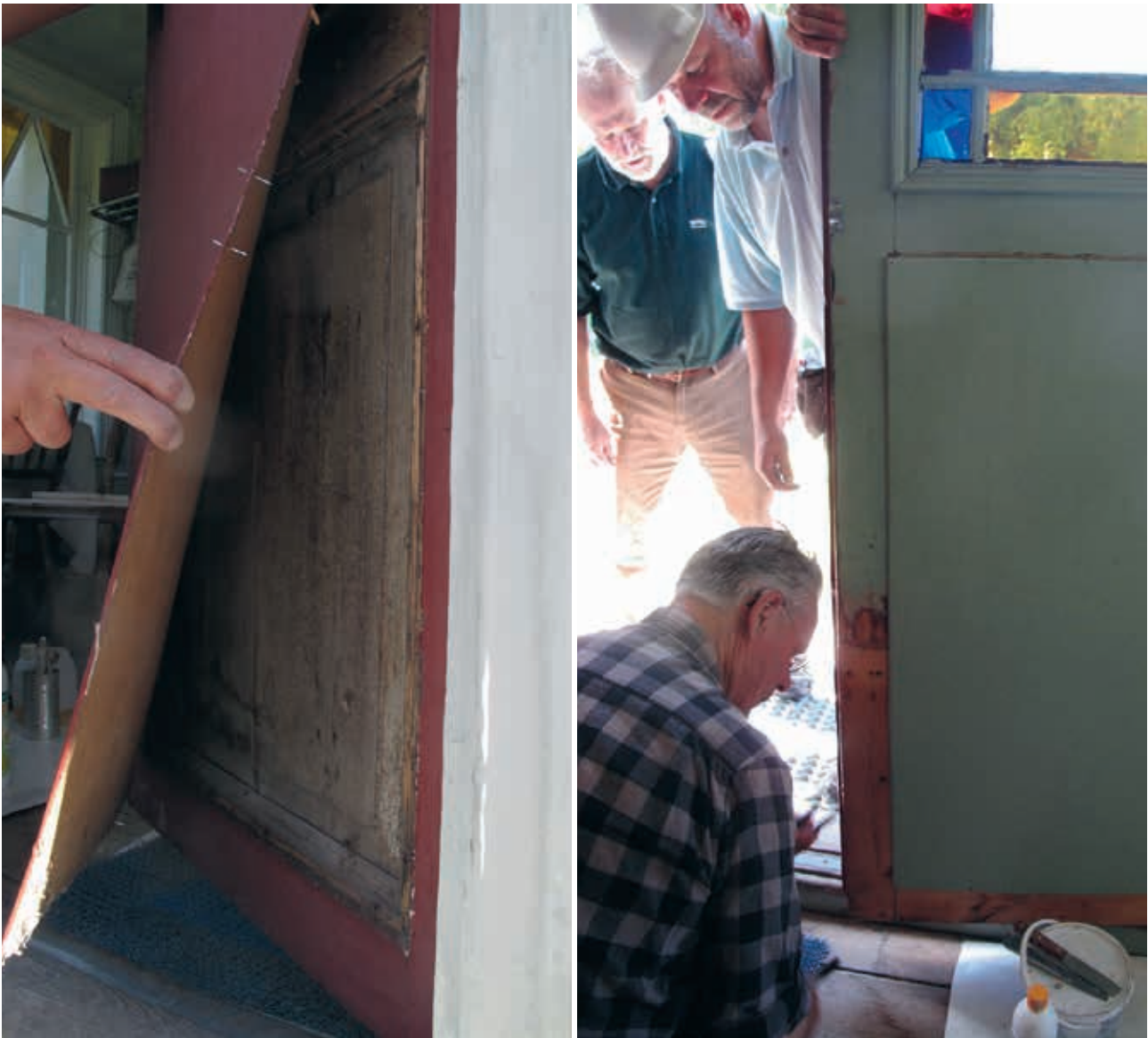
LP 201300783, LP 201300784. Dörrparet täcktes i de två nedre speglarna av masonitskivor både utvändigt och invändigt. Foto H. Bellberg
