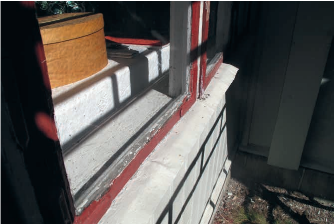
LP 201300778. Glasen i bågarna i verandan satt i mycket tunn kittfals. Bågarnas bottenstycken var dessutom nedslitna. Foto H. Bellberg
