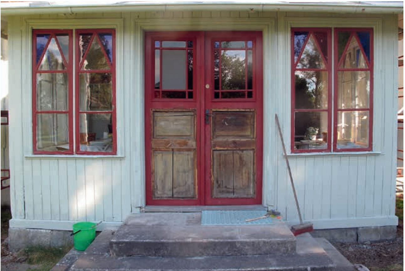
LP 201300786. Pardörrarna med de nedre fyllningarna i speglarna framtagna. Dessa täcktes av masonitskivor innan renoveringen. Foto H. Bellberg
