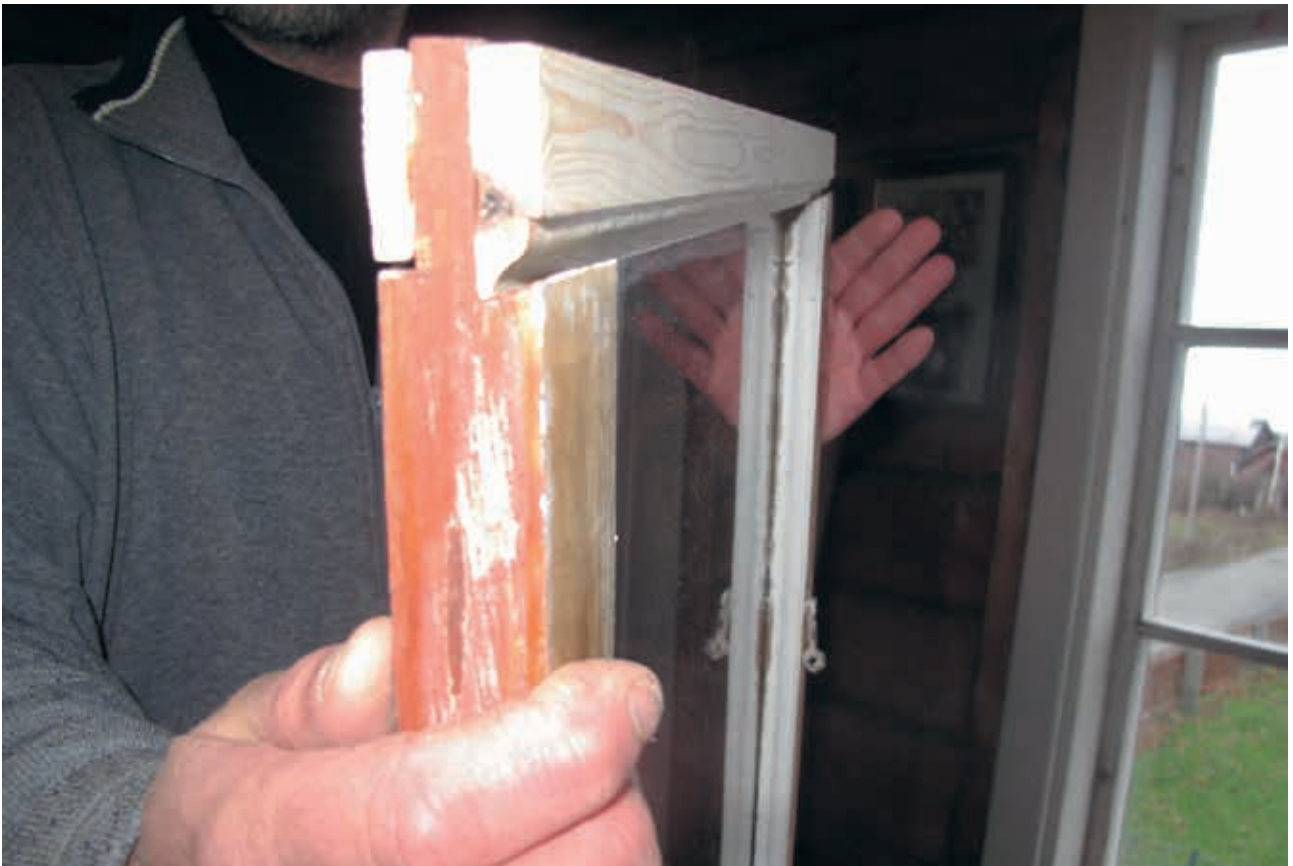
LP 201300781. Felgjorda bottenstycken snidades till på plats för att stämma överens med förlaga. Foto H. Bellberg
