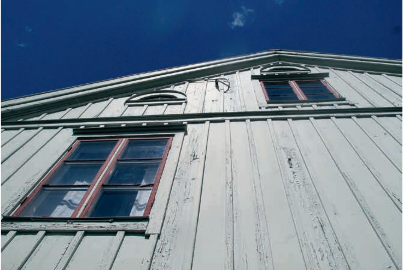
LP 201300772. Fasad mot söder innan ommålning. Foto H. Bellberg
