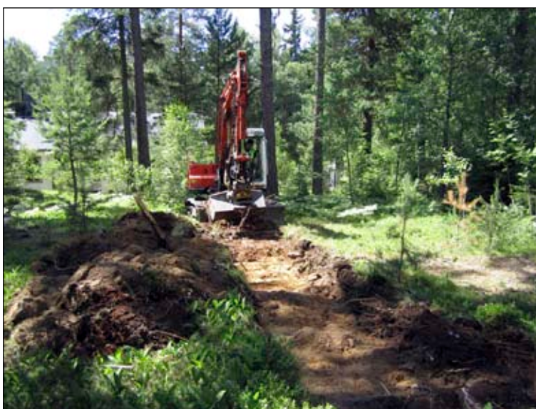
Figur 4. Schaktning pågår inom objekt 14. Foto: Kjell Andersson, bildnr Lp20111017.
