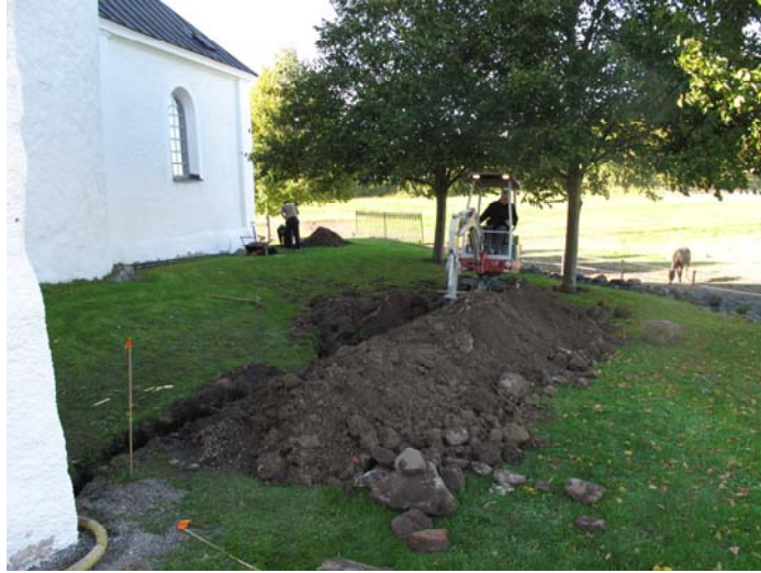
Fig 2. Schaktning norr om kyrkobyggnaden.
