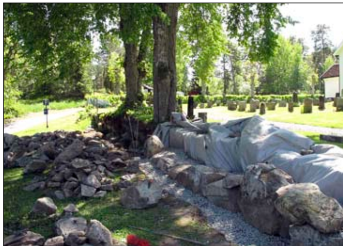
Bogårdsmuren med ny bottning och markduk. Foto Albin Uller 2011. Lp20110421.
