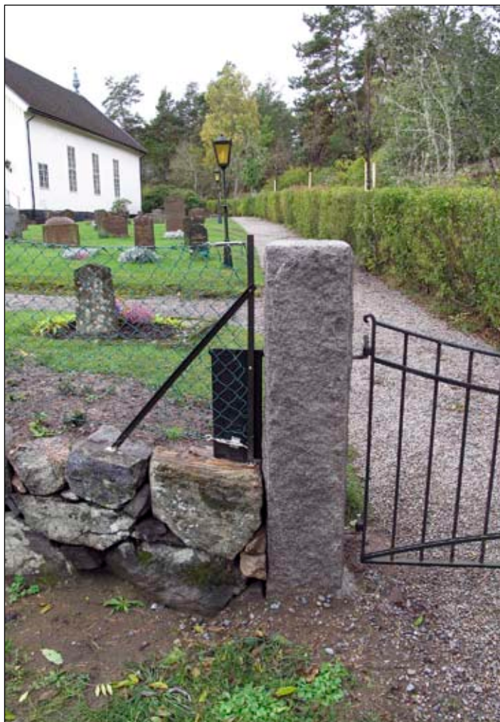
Murens anslutning till en av de nya grindstolparna. Foto Albin Uller. Lp20111021.
