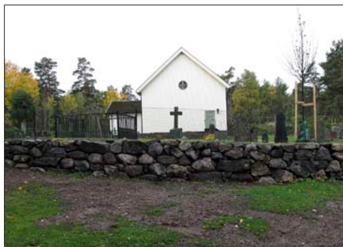
Bogårdsmuren efter omläggning. Foto Albin Uller. Lp20111023.
