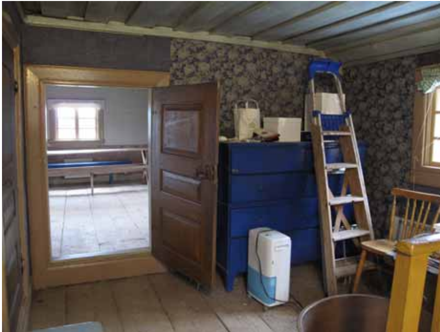
Hallen med vy in i salen. På bortre väggen syns den äldre blå tapeten till vänster och lagningen med en ljusare blommig tapet till höger. Väggytan kommer att bevaras. Lp20100584.
