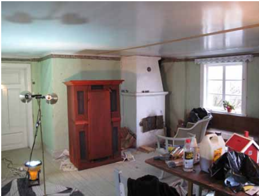
Stugans inre vägg med rörspis och dörr mot hall. Det utskjutande väggpartiet mellan dörr och spis tillkom när bakomvarande kammare omvandlades till kök. I kökets nisch anordnades diskbänken. Lp20100577.
