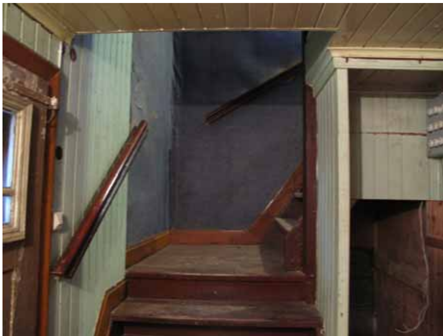
Vy upp i trappan. Till vänster skymtar de nya begagnade innerdörrarna. Till höger syns öppning till skrubben under trappa. Längst in i utrymmet skymtar timmerstommen fram, dvs ena ytterhörnet. Lp20100583.
