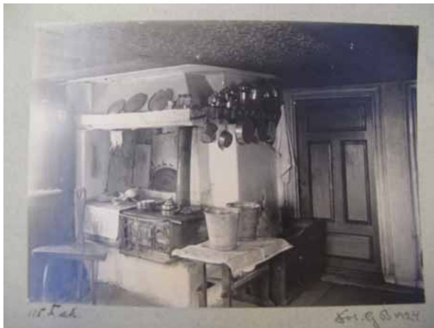
Stugan som den såg ut 1924. Bilden är spegelvänd. Bakugnen har därefter blivit utbytt mot en rörspis. Dörren intill bakugnen sattes igen för att skapa en hel väggyta för den nya köksinredningen i kammaren. Avfotograferat foto. Originalen finns i Nordiska museets arkiv. Fotograf G. Berg 1924.
