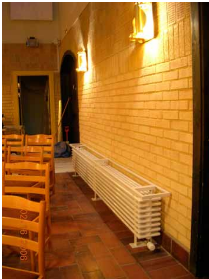
Bänkradiator som skall förses med skiva av ek. Foto: Gunilla Nilsson, 2006, bildnr: lp20110093.
