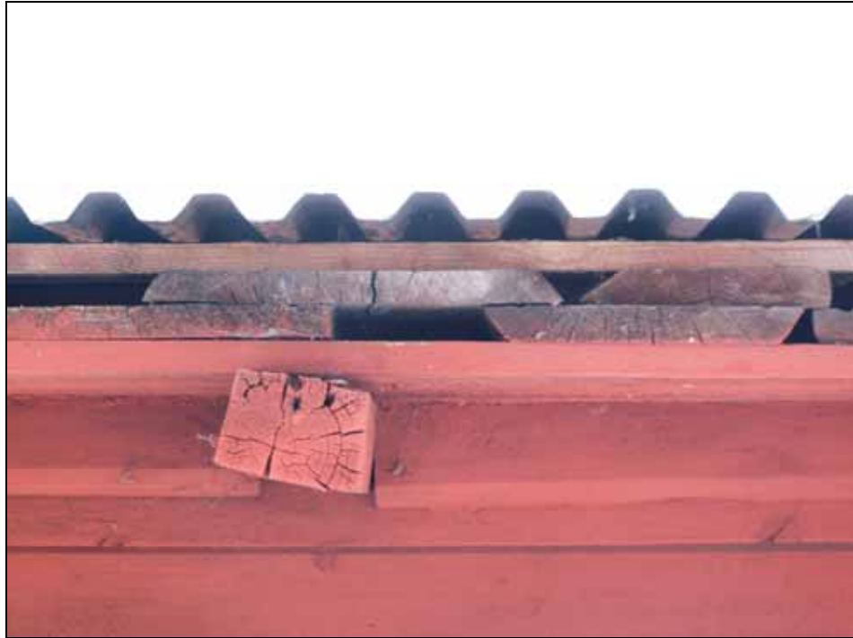
Taket täcks av takbrädor på lock och däröver läkt och korrugerad plåt.
