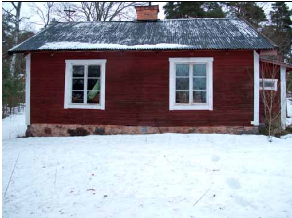
Torpets södra fasad.
