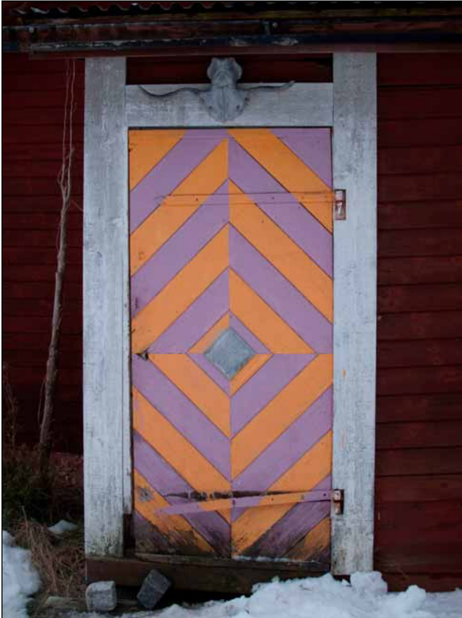
Ytterdörr i farstukvisten utgörs av en bräddörr på utsidan klädd med rombiskt ställd panel och försedd med kraftiga bandgångjärn.
