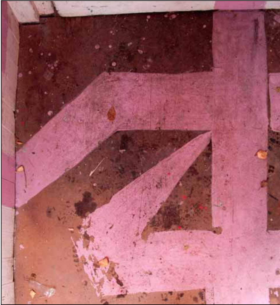
Golvet i farstuvisten är täckt av skivmaterial.
