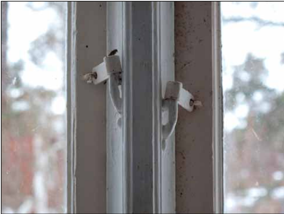
Fönstren har långa och korta uppställningsbeslag av en typ vanlig under 1800-talet.
