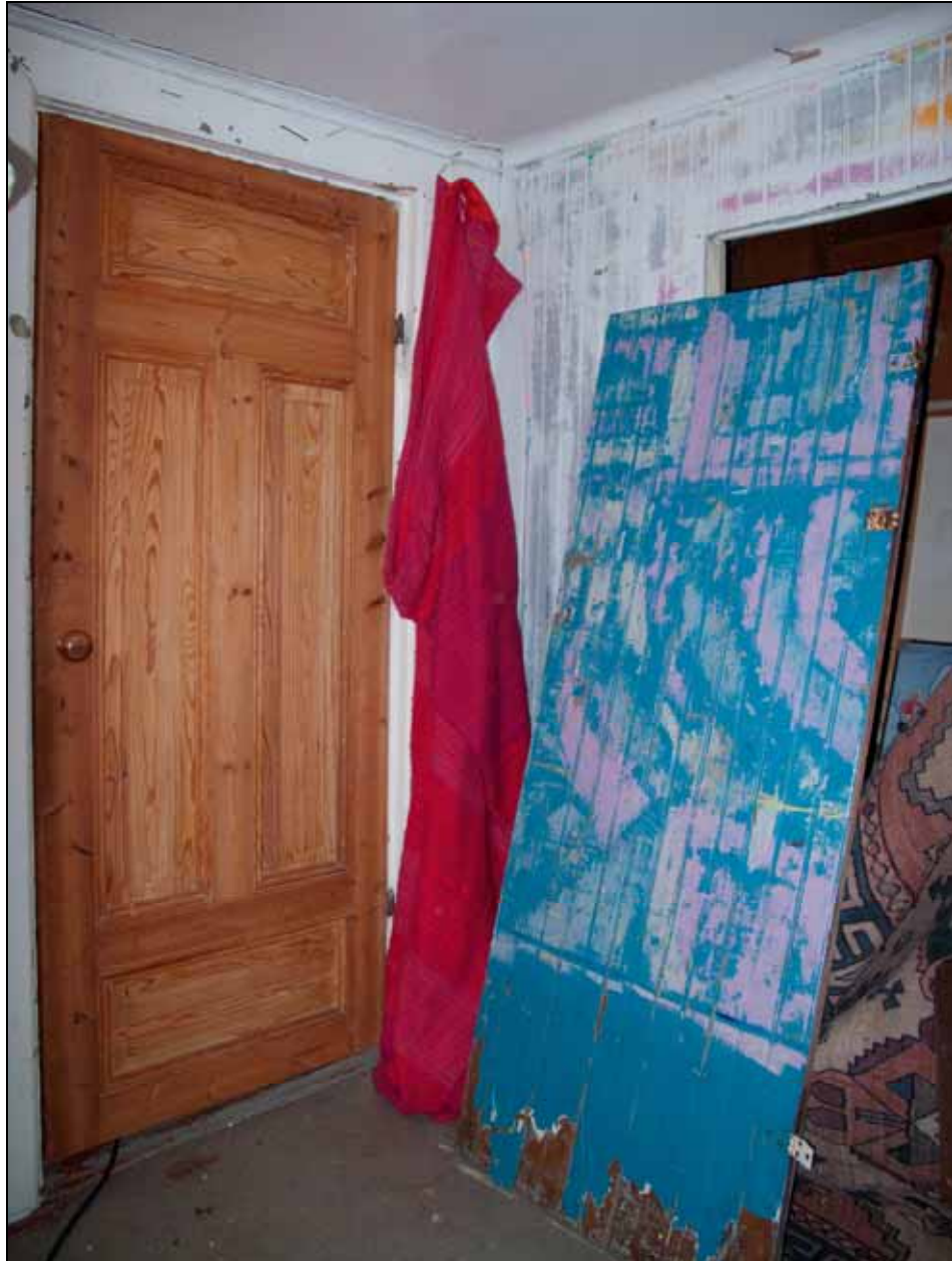
Omålade fyrfyllningsdörr till kammare samt skafferidörr klädd med pärlpontpanel.
