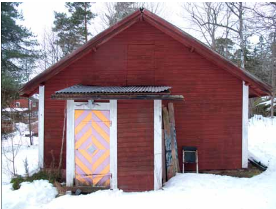
Torpets östra fasad med tillbyggd farstukvist.
