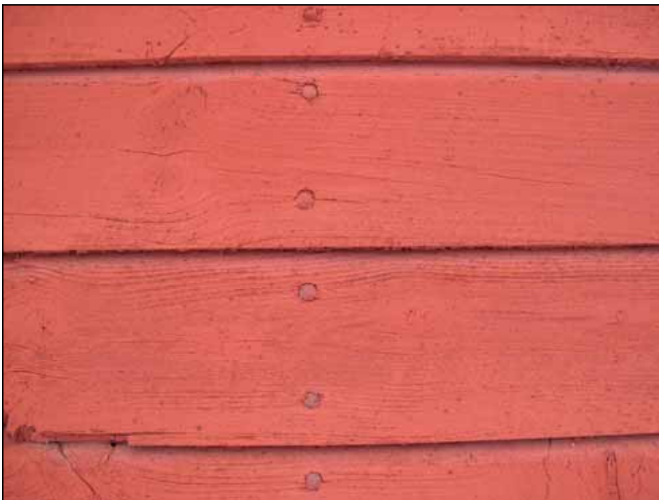
Detalj av torpets fasspontpanelade fasader.
