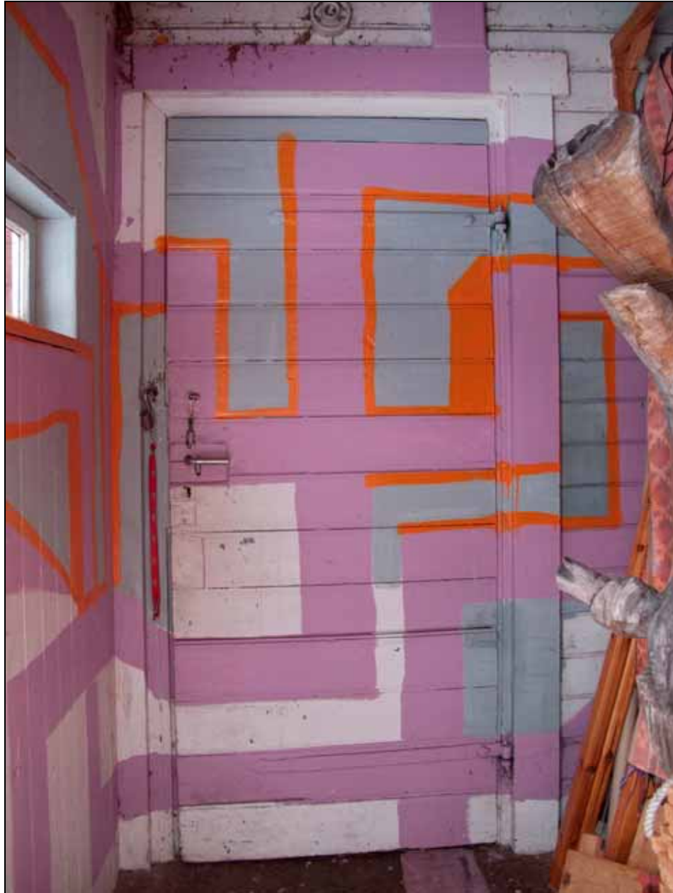
Dörr till kök utgörs av en bräddörr utvändigt klädd med liggande profilerad panel. Troligtvis torpets ursprungliga entré.
