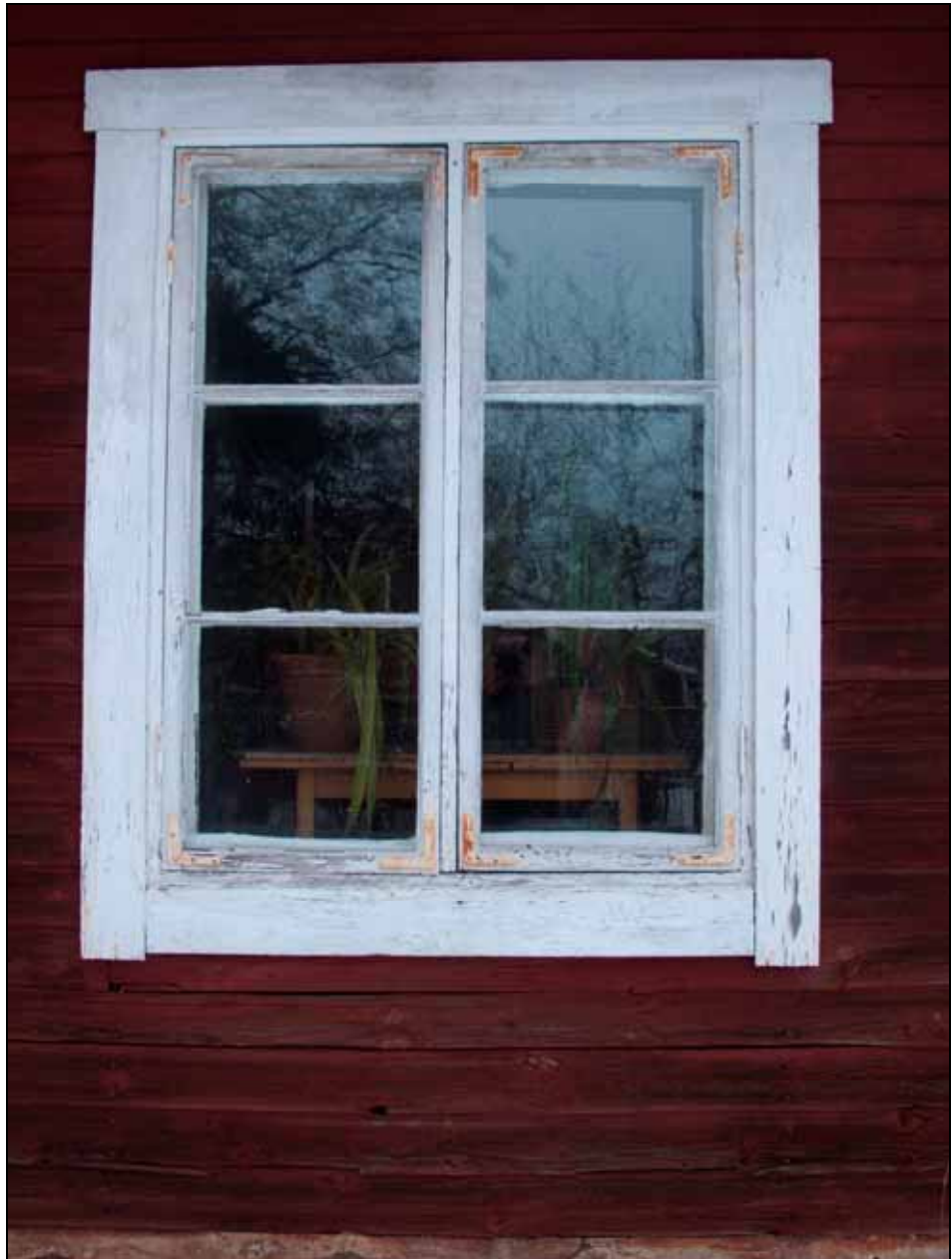
Södra fasadens östra fönster. Enkla sexrutsbågar med pressade hörnjärn.
