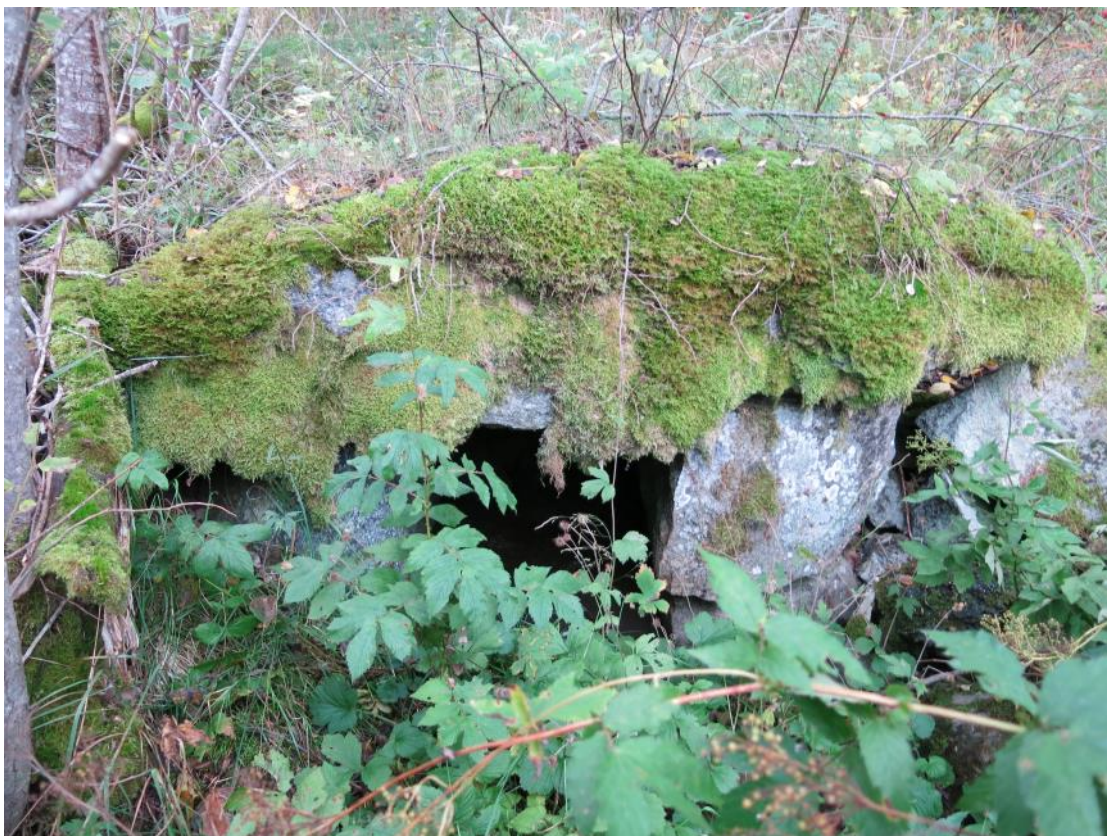
Fig. 9 Den överbyggda vattenrännan A100. Foto från öster.
