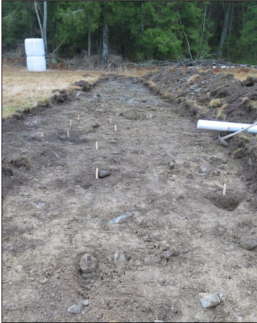
Fig. 8. Stolp-och störhålen med A69 och A81 närmast i bild. Foto från väster.
