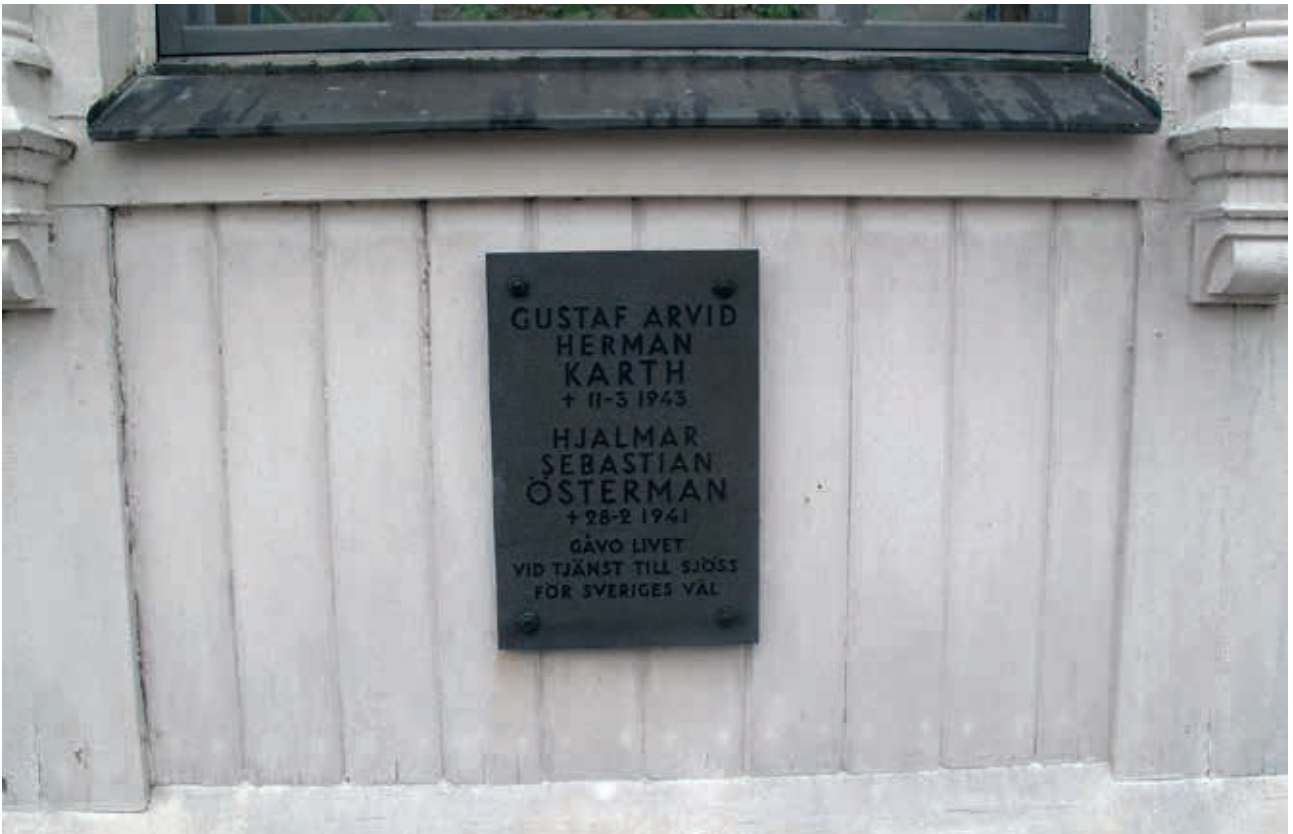
LP 201300570. Stentavlan som är placerad under korfönstret togs ner under arbetet. Tavlan är av på mitten, men snittet är så fint att den ändå fäster. Tavlan återplacerades efter ommålningen. Fotot är taget innan ommålningen. Foto H. Bellberg.
