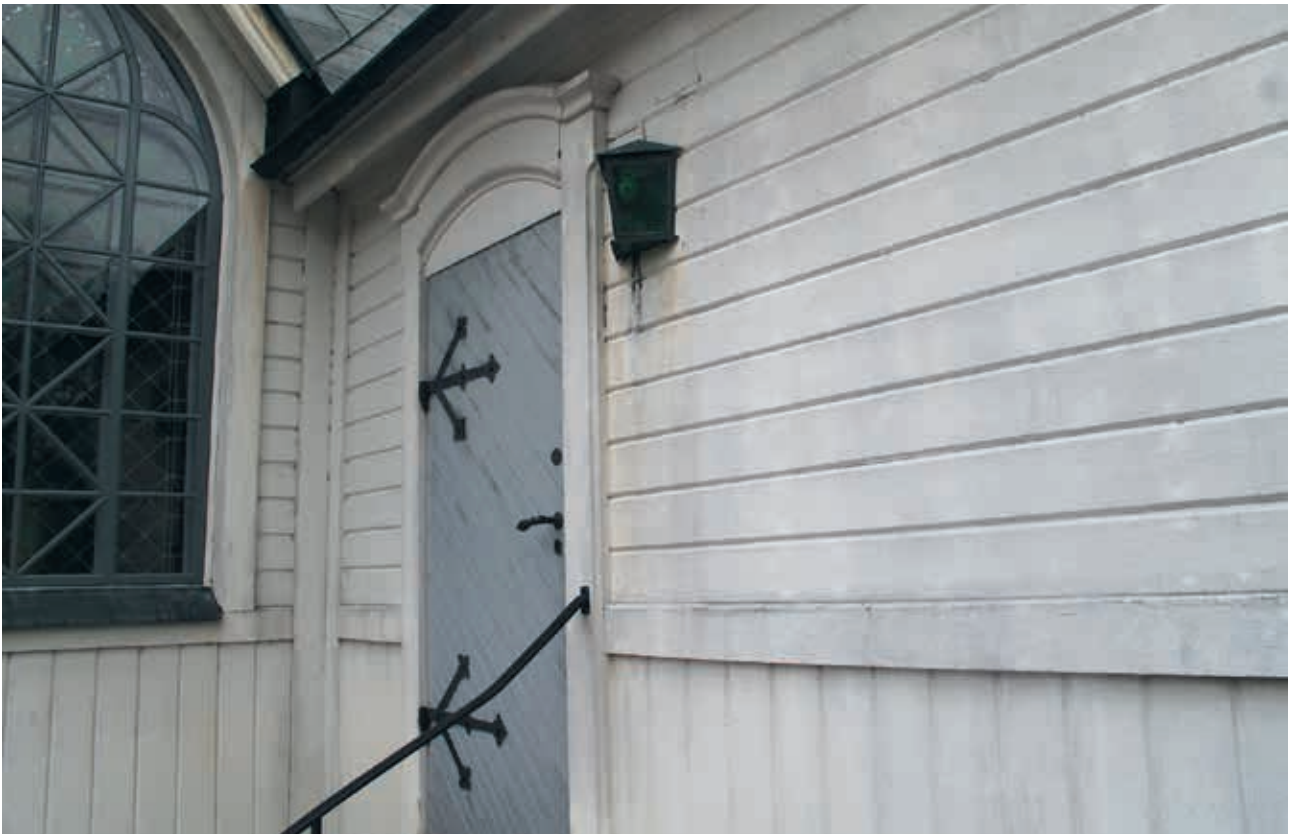
LP 201300571. Fasaden samt dörr- och fönsteromfattningar innan ommålningen. Även de ej inmålade järnen syns i bild. Foto H. Bellberg.
