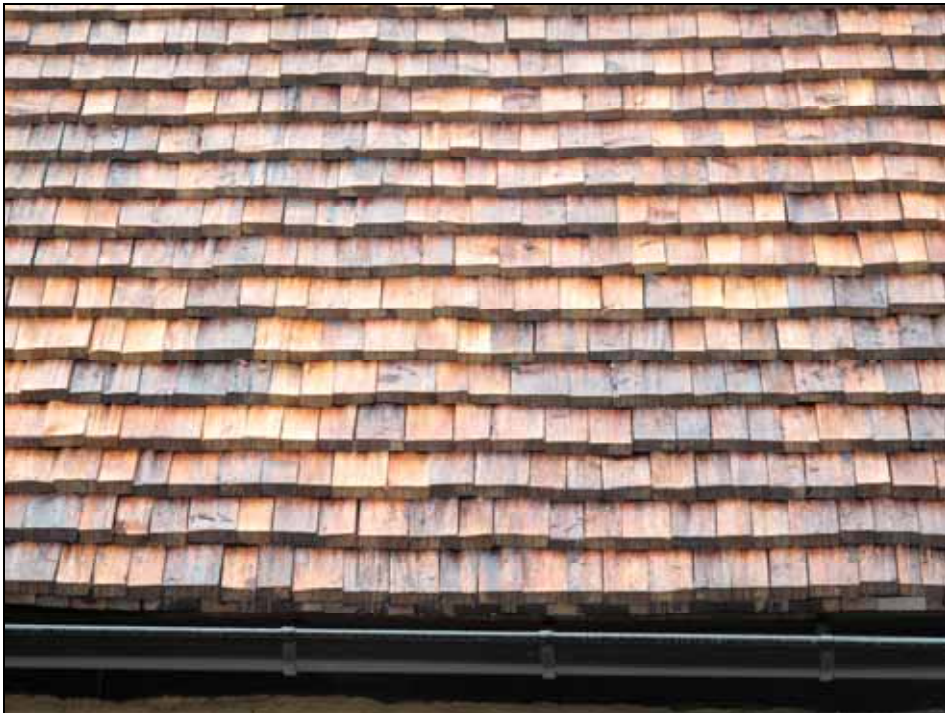
Nya takspån lades med fasad nedre kant som tidigare.
