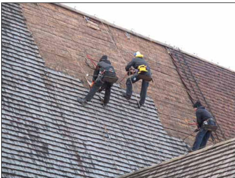
Omläggning av takspån.
