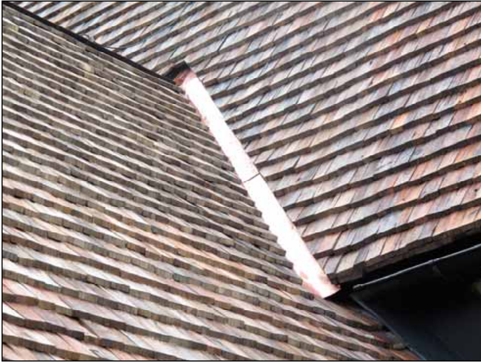
Ny rännal av kopparplåt i anslutning till sakristian.
