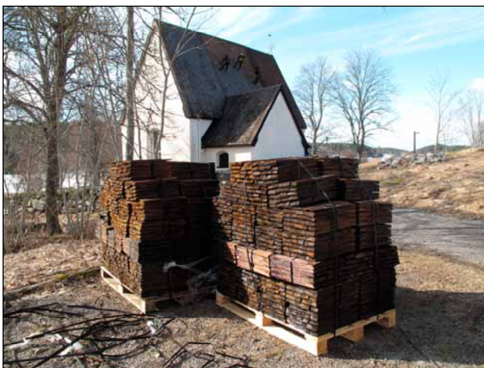
Leverans av nya spjälkade tjärdoppade furuspån.
