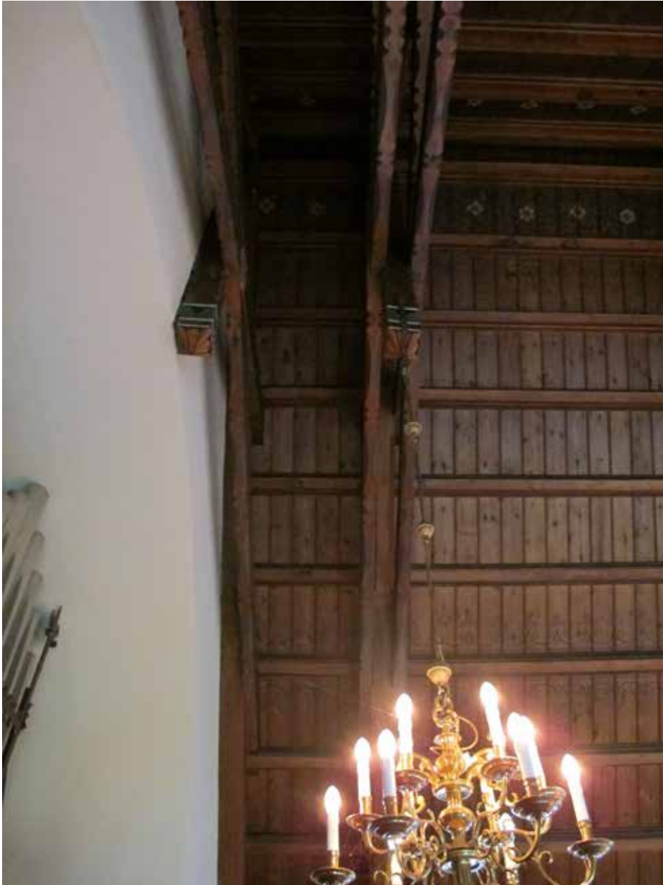
Fig. 20. Takstolen sedd från orgelläktaren innan infästningen av den nya belysningskenan. LP_2014_00220.
