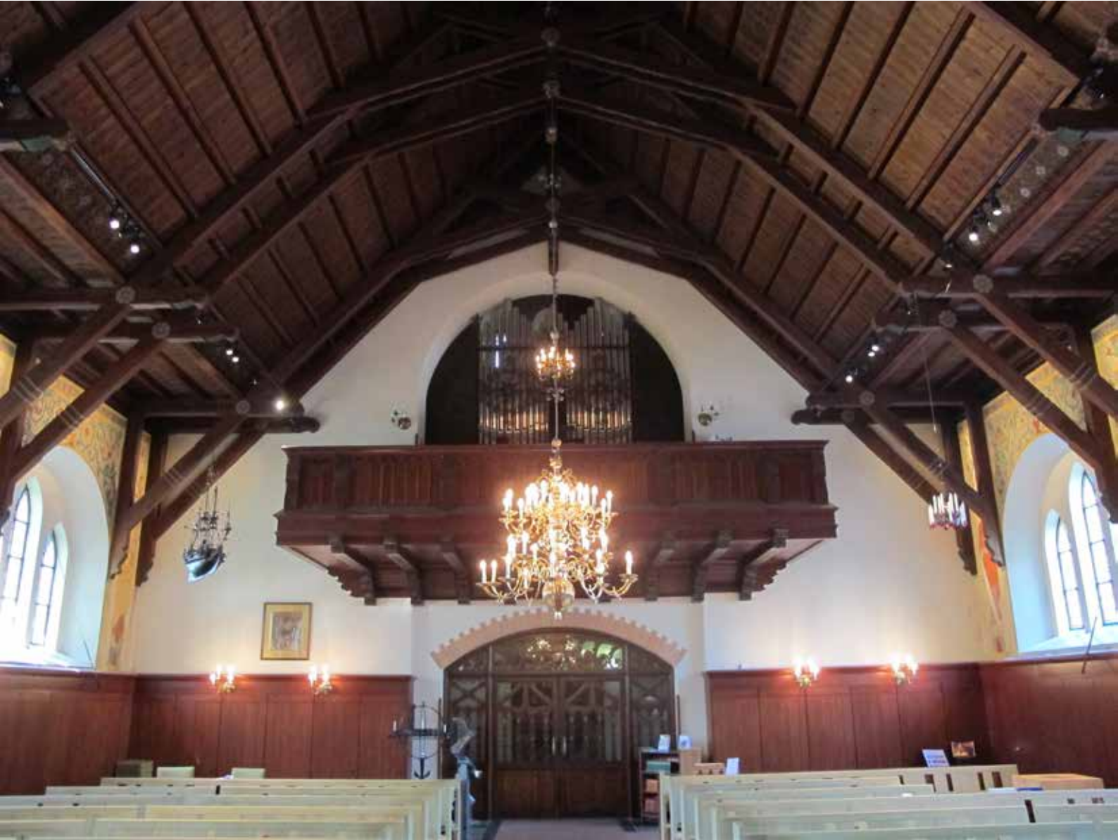
Fig. 23. Takstolen sedd från långhuset innan renoveringen. LP_2014_00221.
