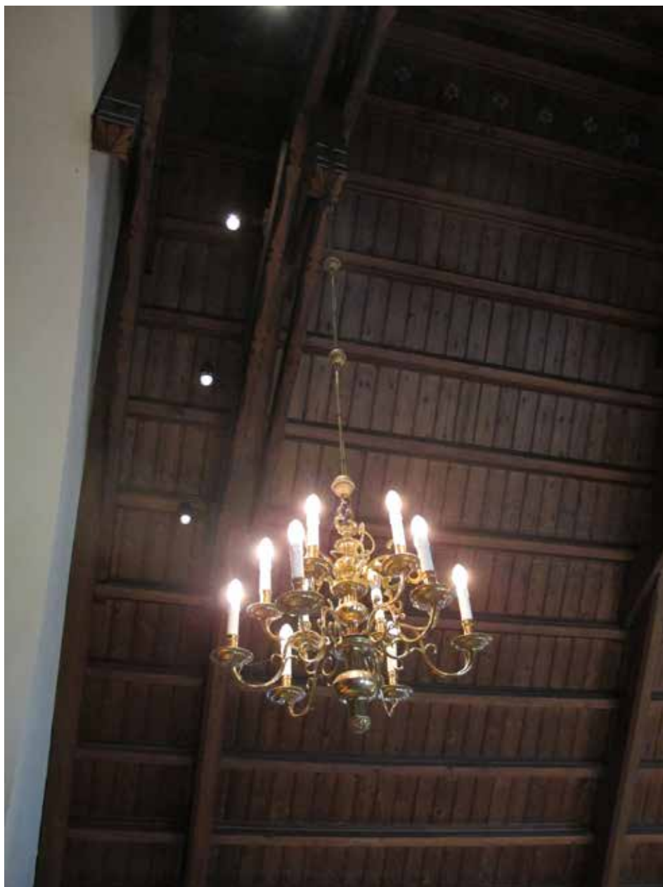
Fig. 21. Övre bilden. Belysningsskenan på plats. LP_2014_00222.
