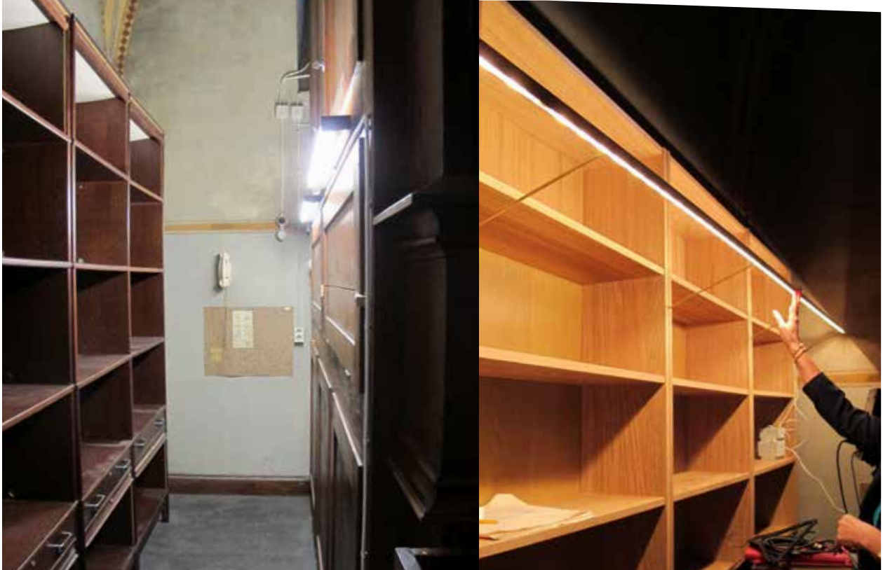
Fig. 18, 19 Hyllorna vid sidan om orgeln före och efter renoveringen. De nya hyllorna fick en ny belysningsskena. LP_2014_00218, LP_2014_00219.
