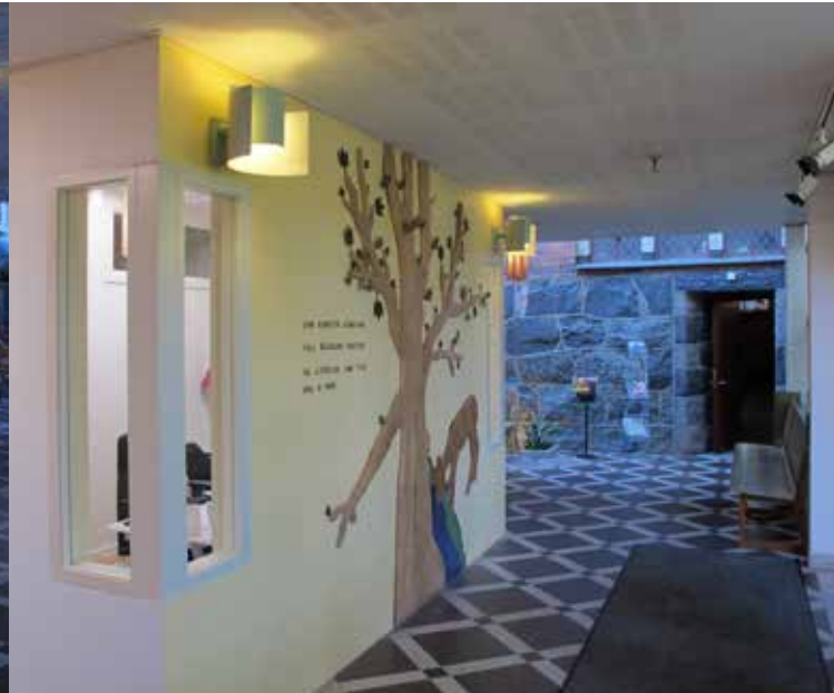
Fig. 8. Efter renoveringen är vägghörnen in till receptionen försedda med fönsteröppningar. LP_2014_00208.
