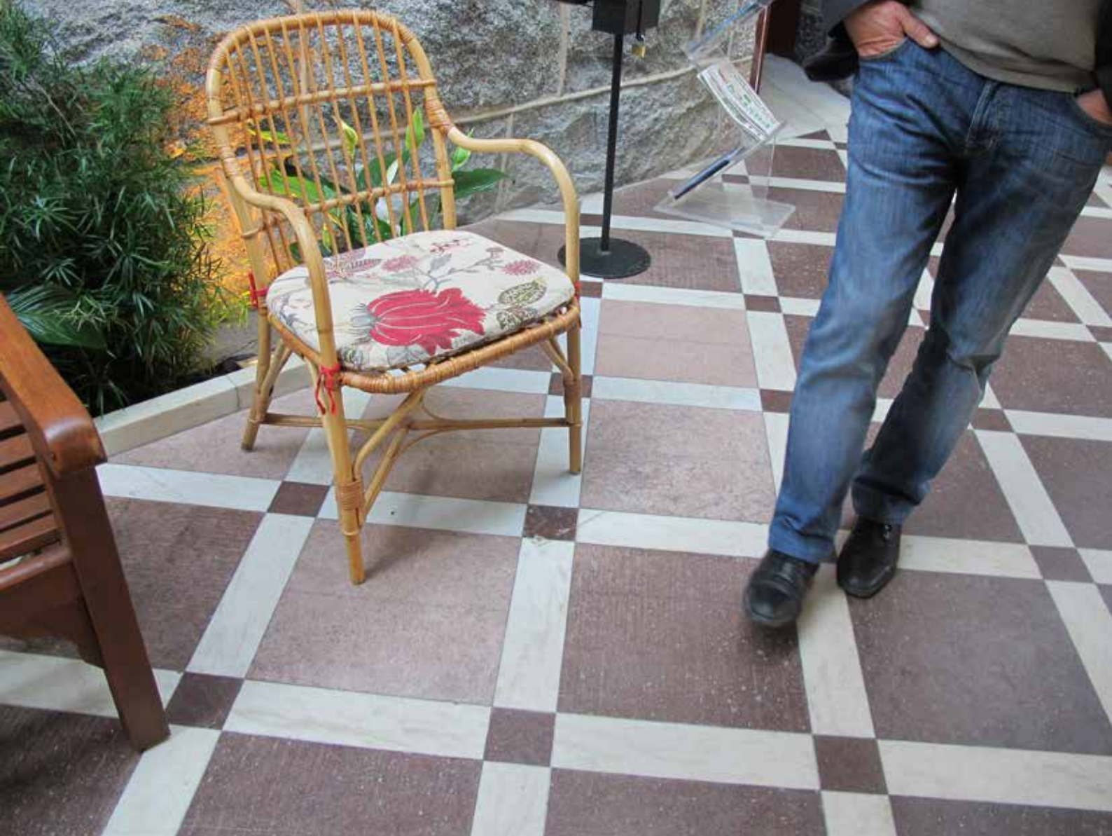
Fig. 6. Golvet kompletterades med välliknande rödrosa Gotlandssten där rabatten smalnats av. LP_2014_00206.
