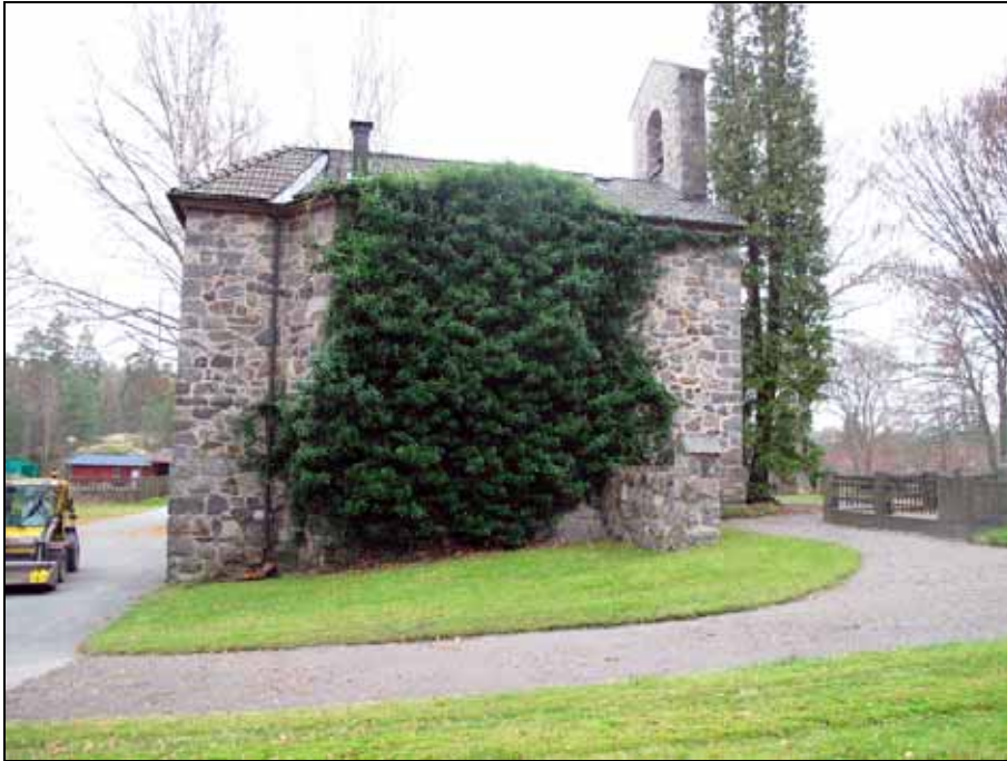
Kapellet från norr med murgröna som täcker fasaden och växer över takfoten. Foto: Gunilla Nilsson, november 2009
