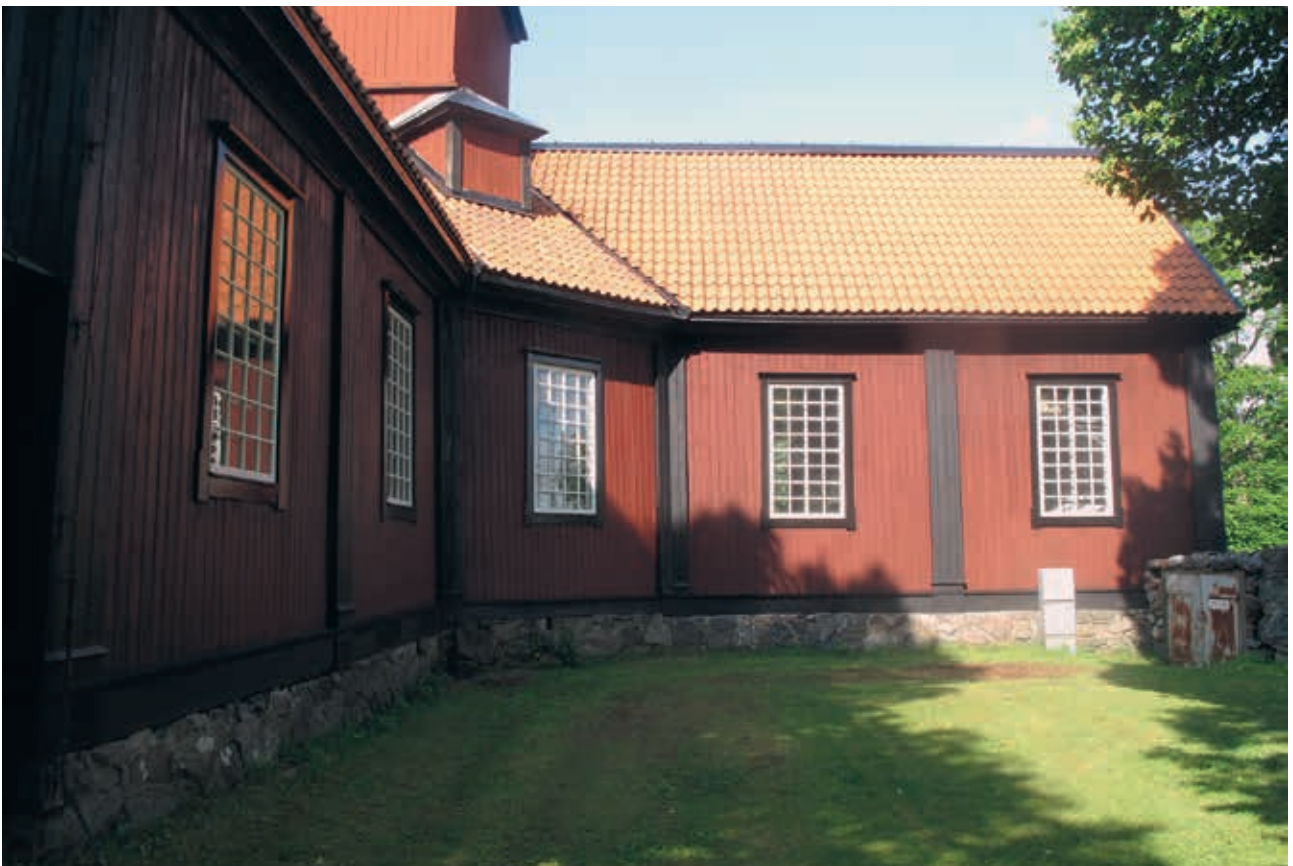
LP 201300542. Norrsidan efter ommålningen, med den fortfarande torkande tjäran.
