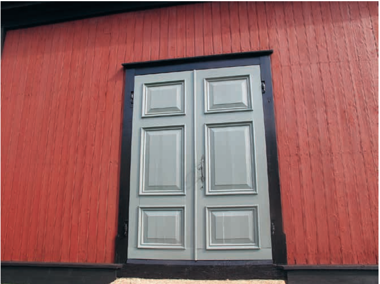
LP 201300549. Dörren på sydsidan efter ommålning och lagning i den mittersta vänstra spegeln samt linoljefärgsmålade dörrfoder.
