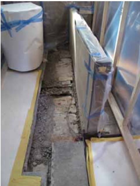
Under korttrappans betong fanns tegel och stångjärn som troligtvis är ena sidan av en murad gravkammare.
