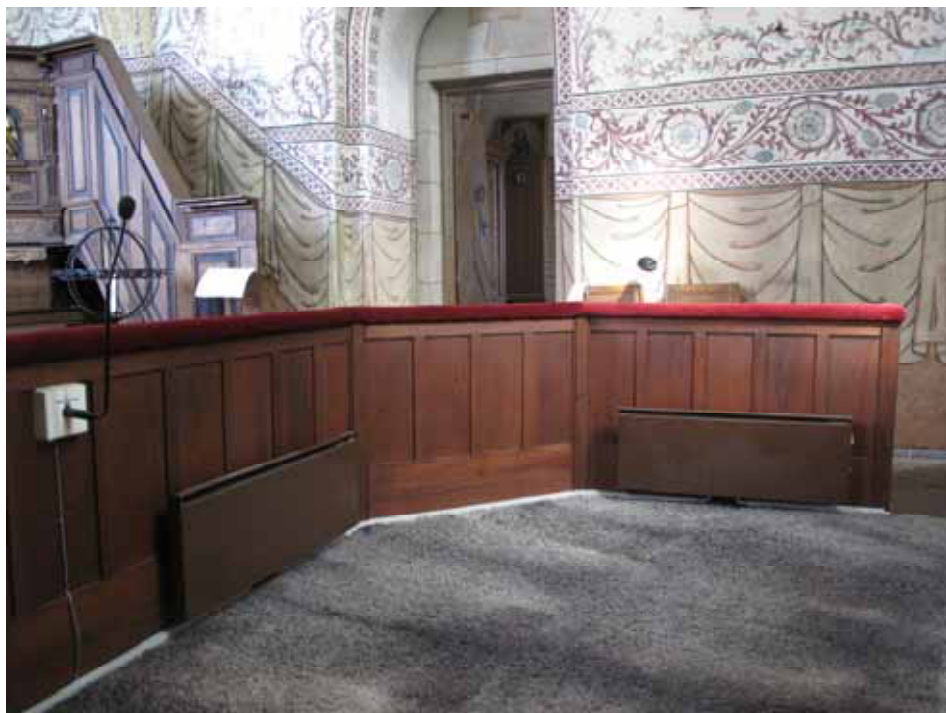
Altarringen före åtgärd med trägolv
