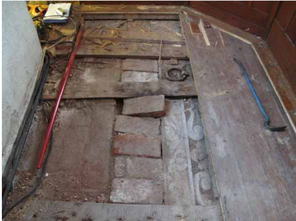
Altarringens trägolv demonterades och underliggande golvyta var belagd med tegel närmast altaret och gravhällar.
