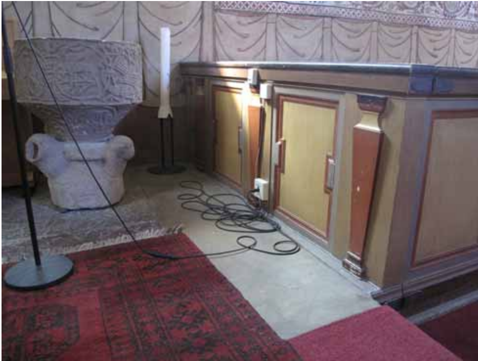
Korttrappan bestod av betong, undantaget mittdelen som var av kalksten. Betongen avlägsnades och ersattes av kalksten.
