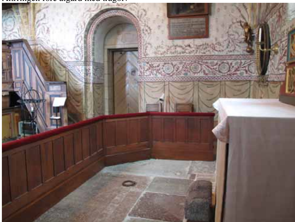
Altarringen efter golvomläggning. Trägolvet är borttaget och altarringen står direkt på stengolvet.
