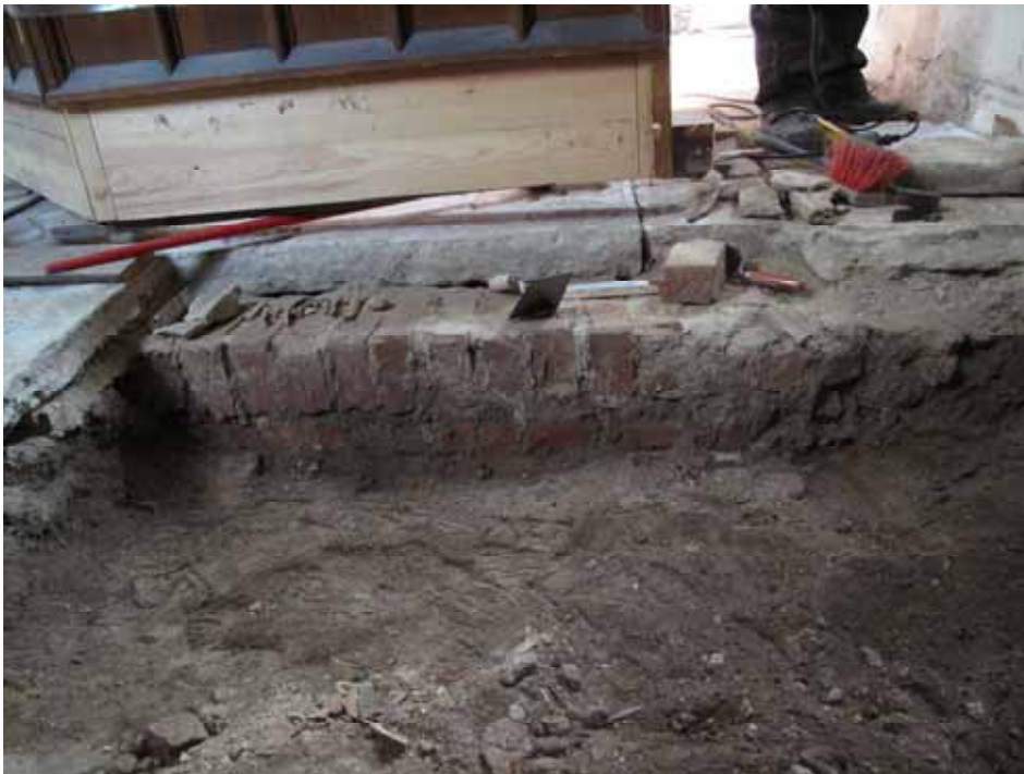
I schaktets norra kant frilades övre delen av det öppnade gravrummets yttre sydmur.
