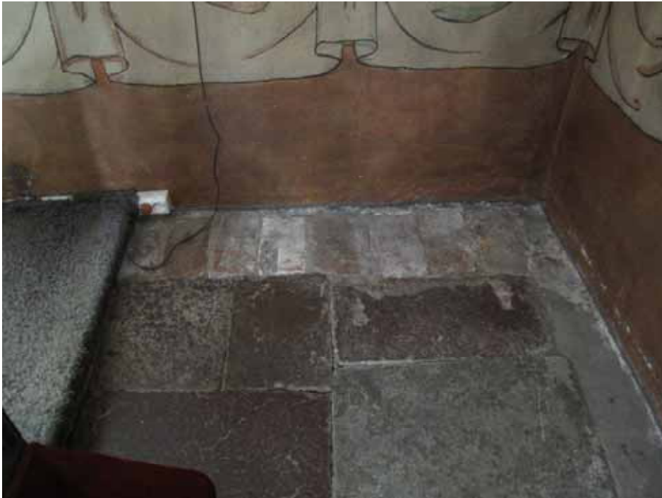
Korets sydösthörn före åtgärd. Utmed östväggen löpte en tegelram.
