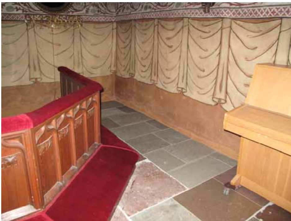
Koret efter åtgärd med nylagd kalksten utmed södra väggen.
