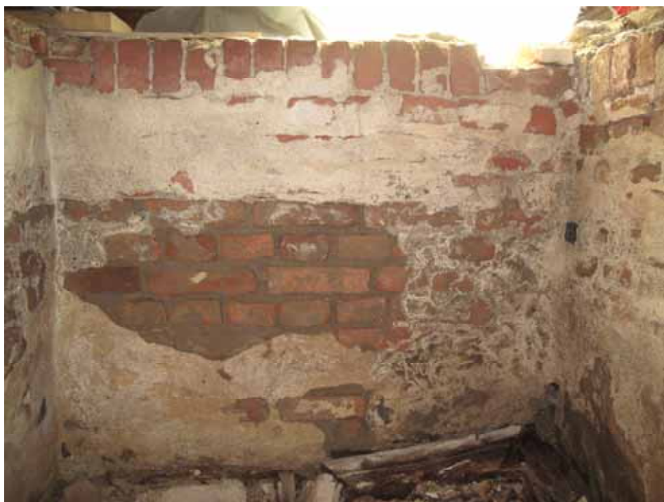
Gravrummets södra vägg. Tegelmurverket har varit putsat och vitkalkat.
