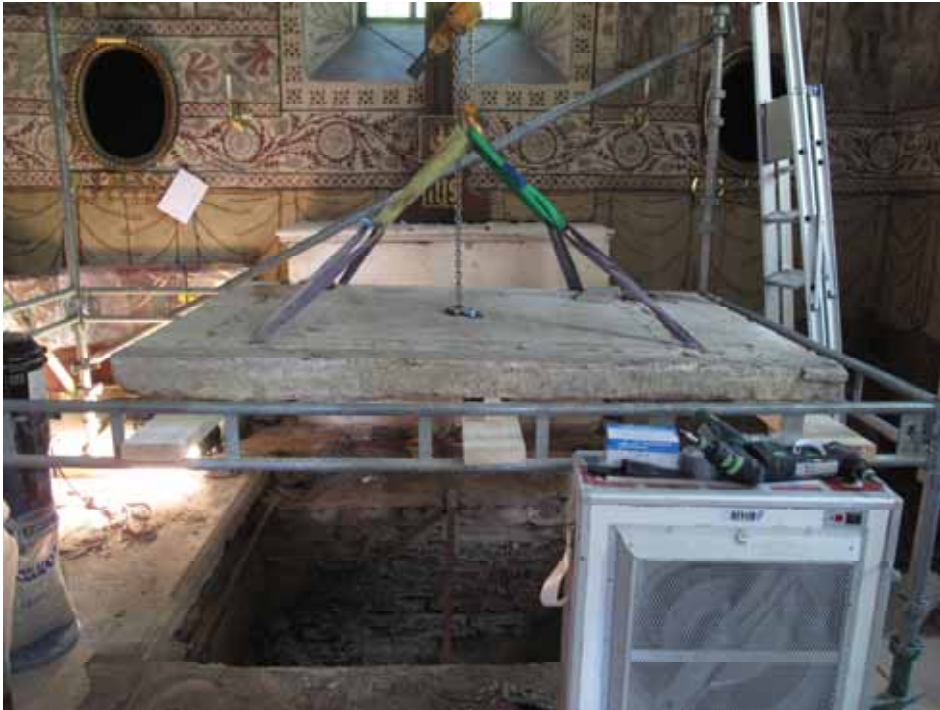
Den centralt belägna gravhällen lyftes för kontroll av fukt i underliggande gravrum.
