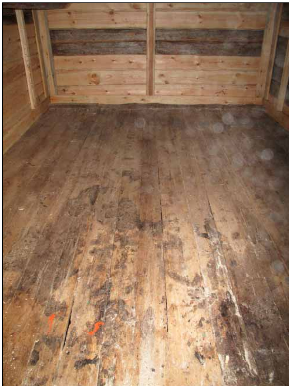
Sjöbodens interiör efter renovering. Här syns det återplacerade golvet samt de nya följarna. Foto Albin Uller. Lp20111711.
