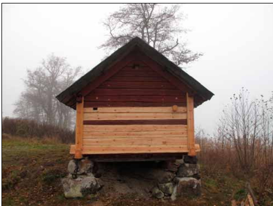
Den bakre gaveln efter renoveringen. Nya hål har tagits upp och golvet har återplacerats. Foto Albin Uller. Lp20111705.
