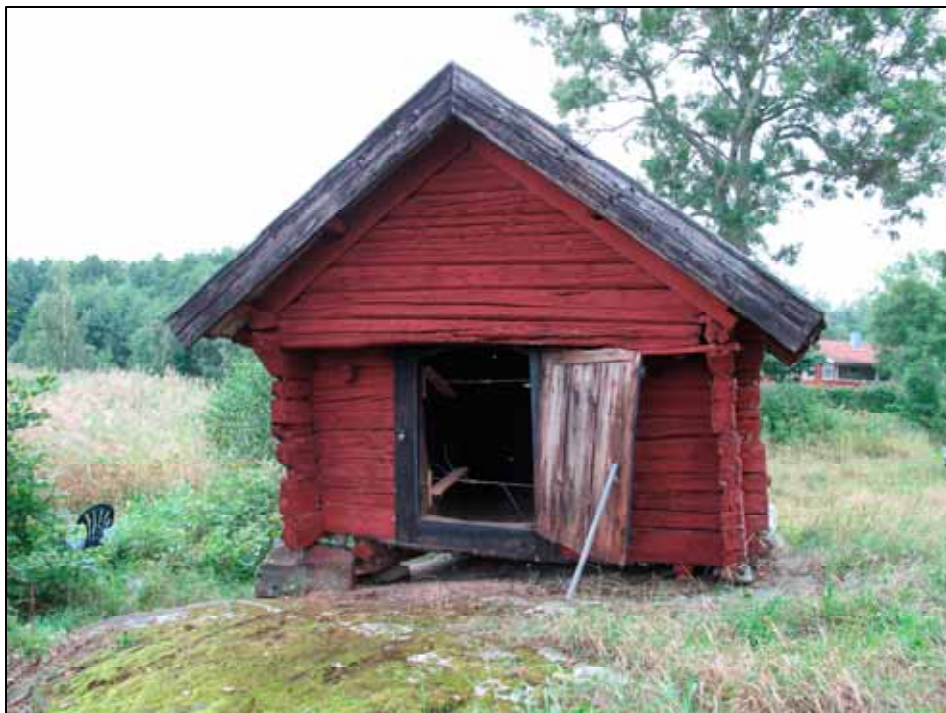
Sjöbodens entrésida innan renovering. Foto Albin Uller 2011. Lp20111699.
