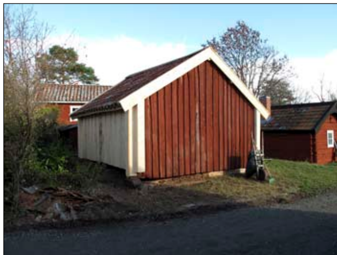
Vedboden från nordväst efter renovering. Foto Albin Uller Lp20111255.
