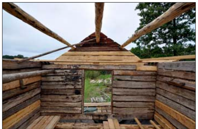
Sjöbod B med renoverat och vänt gavelröste samt nya åsar. Foto Albin Uller Lp20111236.
