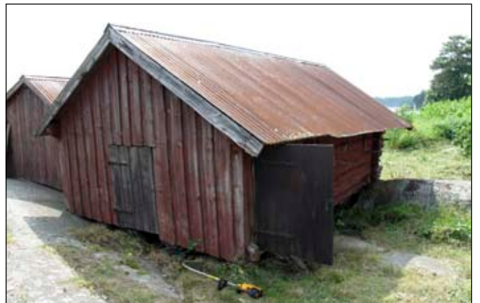
Sjöbod B från nordost innan renovering. Foto Albin Uller Lp20111247.
