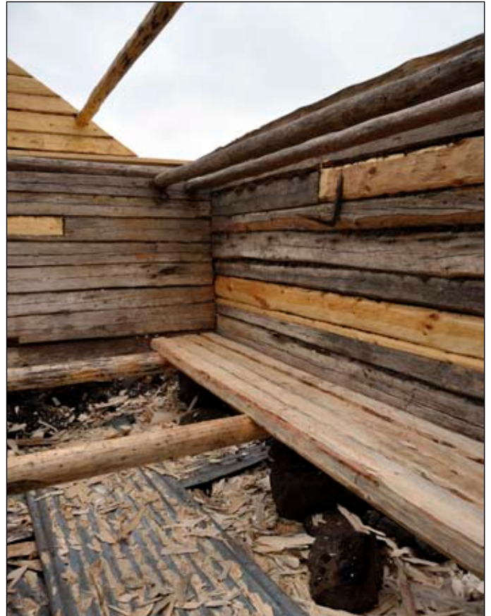
Det flatbilade golvet under renovering. Foto Albin Uller Lp20111233.
