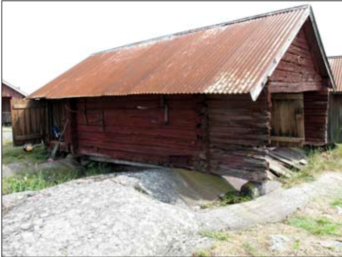
Sjöbod B från nordväst innan renovering. Foto Albin Uller Lp20111245.
