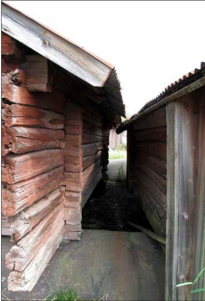
Bilden visar takens överlappning innan renoveringen. Foto Albin Uller Lp20111202.
