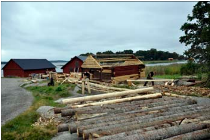
Sjöbod B under renovering. Här syns tydligt hur det östra gavelröstet är utflyttat. Foto Albin Uller Lp20111199.
