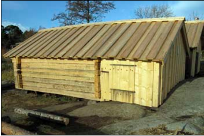
Sjöboden från sydost efter renovering. Foto Albin Uller Lp20111218.
