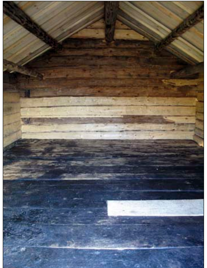
Golvet i sjöbod A efter renoveringen. Foto Albin Uller Lp20111205.
