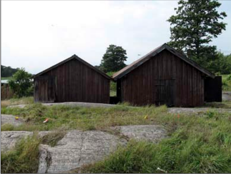
Bilden visar bodarnas placering innan renoveringen. Foto Albin Uller Lp20111200.
