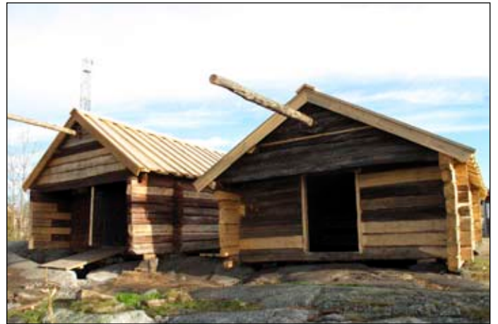
De nya stockarna som sticker ut genom gavelröstena. Foto Albin Uller Lp20111204.
