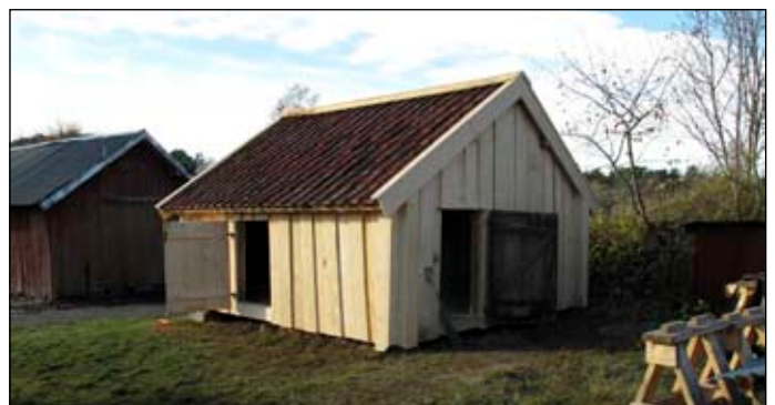
Vedboden från sydost efter renovering. Foto Albin Uller Lp20111253.
