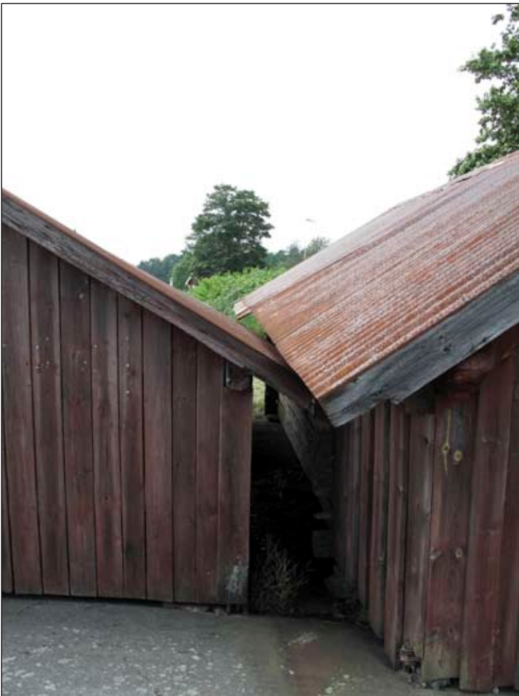
Bilden visar takens överlappning innan renovering. Foto Albin Uller Lp20111201.
