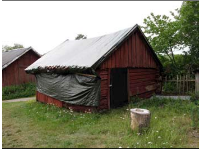
Vedboden från sydost innan renovering. Foto Albin Uller Lp20111249.
