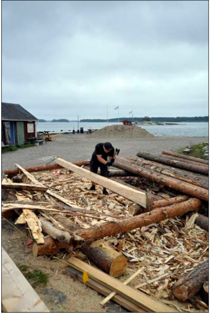
Timmer till sjöbod A bilas på plats. Foto Albin Uller Lp20111220.
