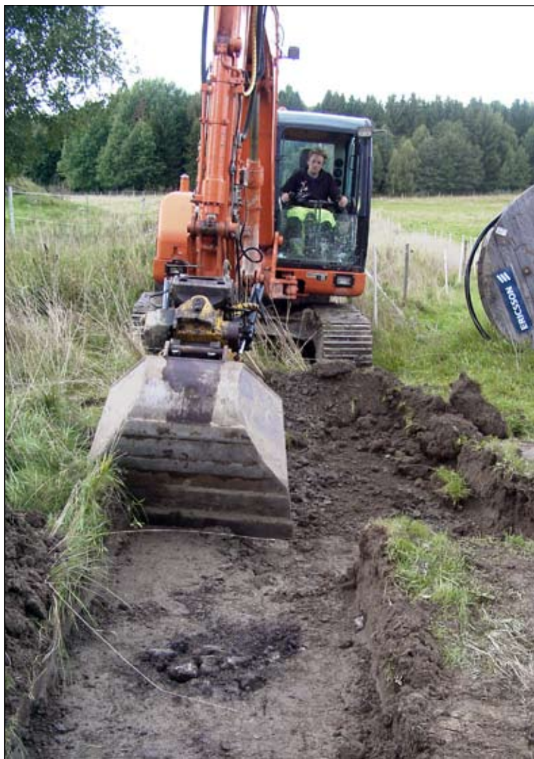
Fig 3. Här syns den härd som framkom vid schaktning. Foto G Werthwein, bild nr lp20100486.
