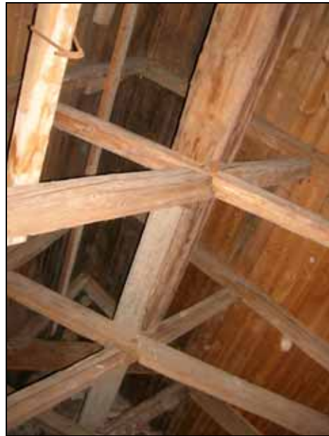
Knäbock vid takfoten av sparren består av stickbjälke och stödben, en konstruktion som tillhör de gotiska taklagen. Takstol med saxsparre. På takstolen ligger lösvirke. Bildnr: lp20100211 och lp20100212
