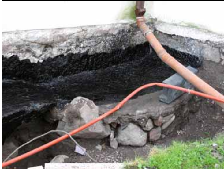
Rester av murad trumma i vinkel mellan sakristian och långhuset. Bildnr: lp20100220
