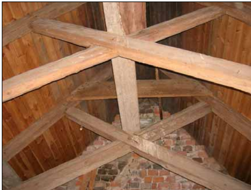
Längt i norr är taklaget förstärkt med hanbjälke. Lösvirke vilar på saxsparrar. Bildnr: lp20100207
