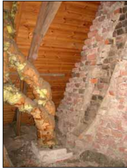
T. v. Takfall mot väster med genombång för ventilation. T. h. Sotspår på norrgaveln efter murstock från 1900-talets början. Bildnr: lp20100210 och detalj av lp20100210
