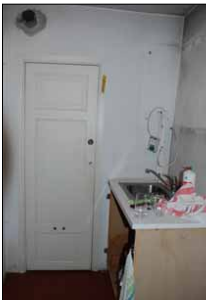
Utrymme i källaren före ombyggnad. Bildnr: lp20100203
