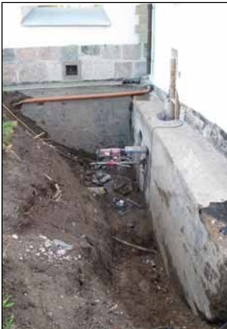
Håltagning i betonggrund för ny entré. Bildnr: lp 20100223
