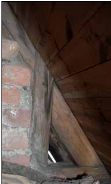
Knäbock vid takfoten av sparren består av stickbjälke och stödben, en konstruktion som tillhör de gotiska taklagen. Takstol med saxsparre. På takstolen ligger lösvirke. Bildnr: lp20100211 och lp20100212
