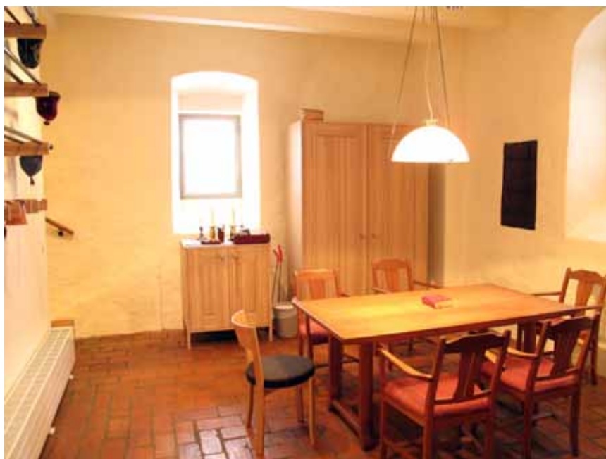
Sakristian efter renovering 2009. Tegelgolvet har rengjorts och behandlats med olja. Bildnr: lp20100229
