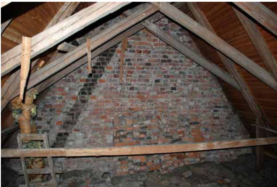
Norra gaveln. På det med mineralullsmattor isolerade vindshjälklaget ligger ett upplag med murtegel. Bildnr:lp20100209
