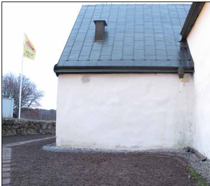
Sakristians västfasad efter avslutade arbeten med grunden. Nylagda kalkstensplattor i markyta för gräsplantering Bildnr: lp20100227
