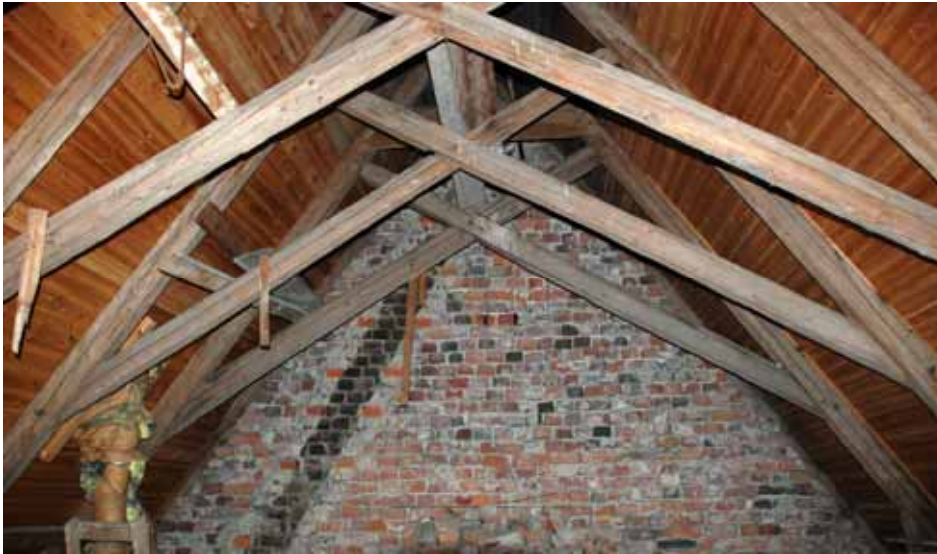
Sakristians takstol är av typen saxsparre med dymlingar. Takstolens ålder är okänd. Förstärkning av takstolen har gjorts vid ett ev flera tillfällen. Gavelröste mot norr murat av tegel, saknar spår av påbyggnad. Bildnr: lp20100208
