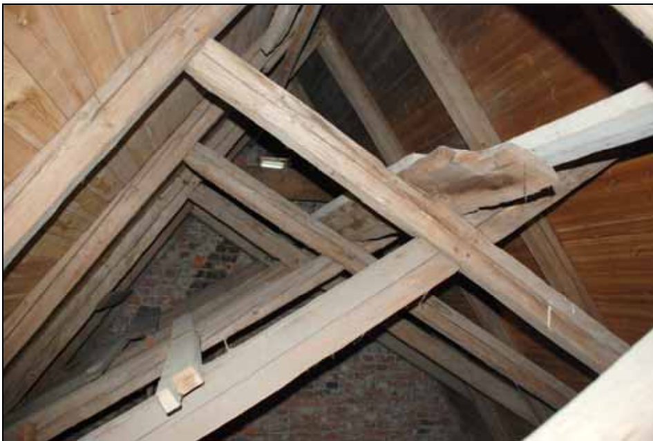
Del av takstolarnas konstruktion sett mot norr. Bildnr: lp20100214
