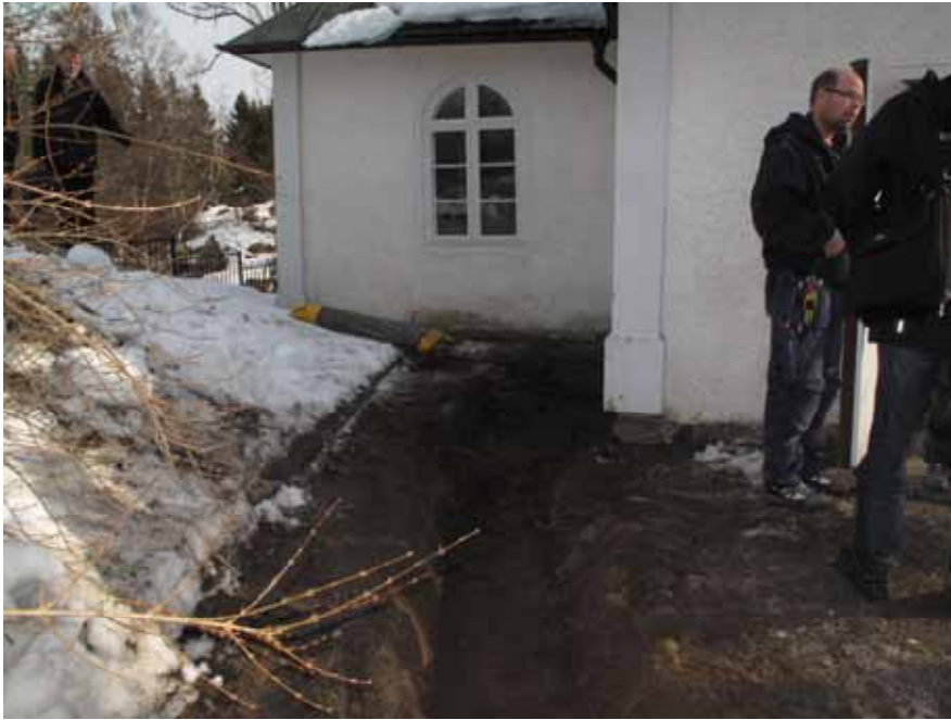
Ledningsschakt grävdes mellan kyrkan och den nya sprinklercentralen bakom förrådet. Endast omrörda jordlager berördes. Foto Cecilia Pantzar 2011. Lp20110551.
