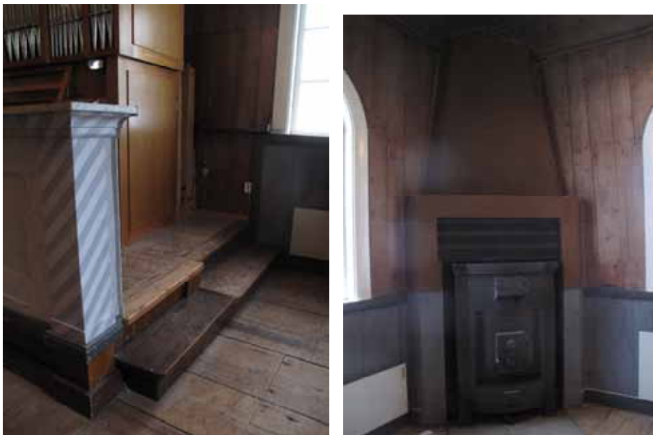
Tv. Orgelläktaren före renovering. Trappans lapptäcke justerades till en mer enhetlig komposition. Th. Den gamla kaminen före åtgärd. Murstocken intog en lättare siluett efter ny färgsättning. Foto Cecilia Pantzar Lp20110554 och Lp20110555.
