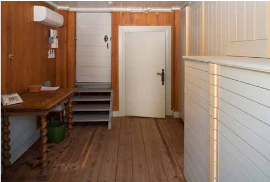
Vy över sakristian i ny skepnad med frilagt såpat golv. Dörrarna leder till predikstol och kyrkorum. Till höger syns den nya skåpinredningen. På väggen till vänster sitter styrsystem och inledelen till luftvärmepumpen.
