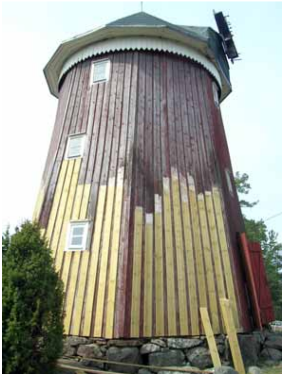
Efter renovering av fasadpanelen. Bildnr: lp20100245
