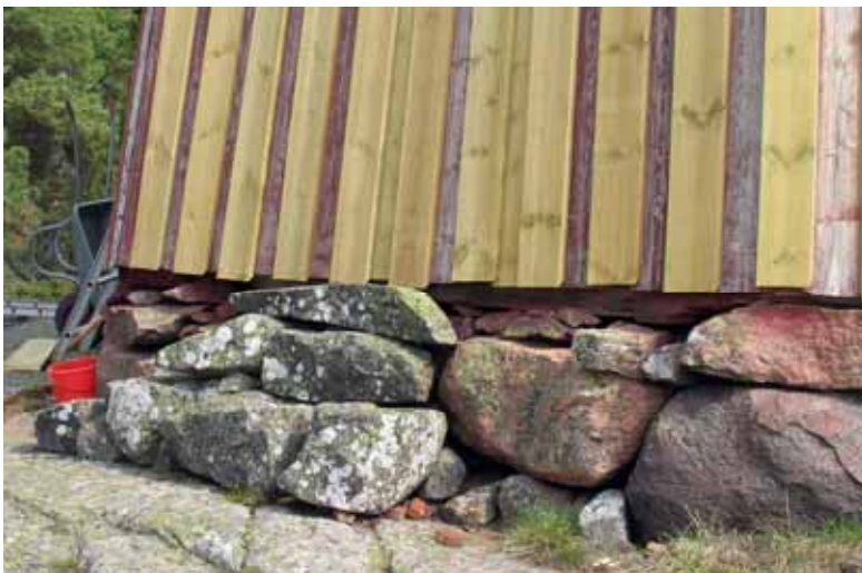
Detalj av stenlagd grund och renoverad fasad. Bildnr: lp20100246
