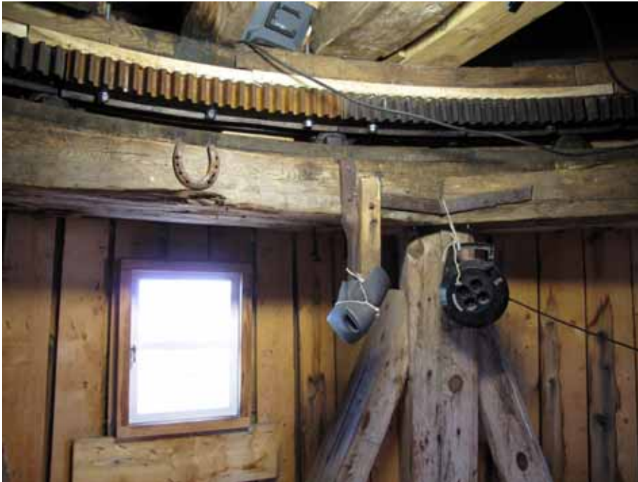
Nytt kuggsegment, gjutet manuellt och monterat i kuggkransen. Bildnr: lp 20100241
