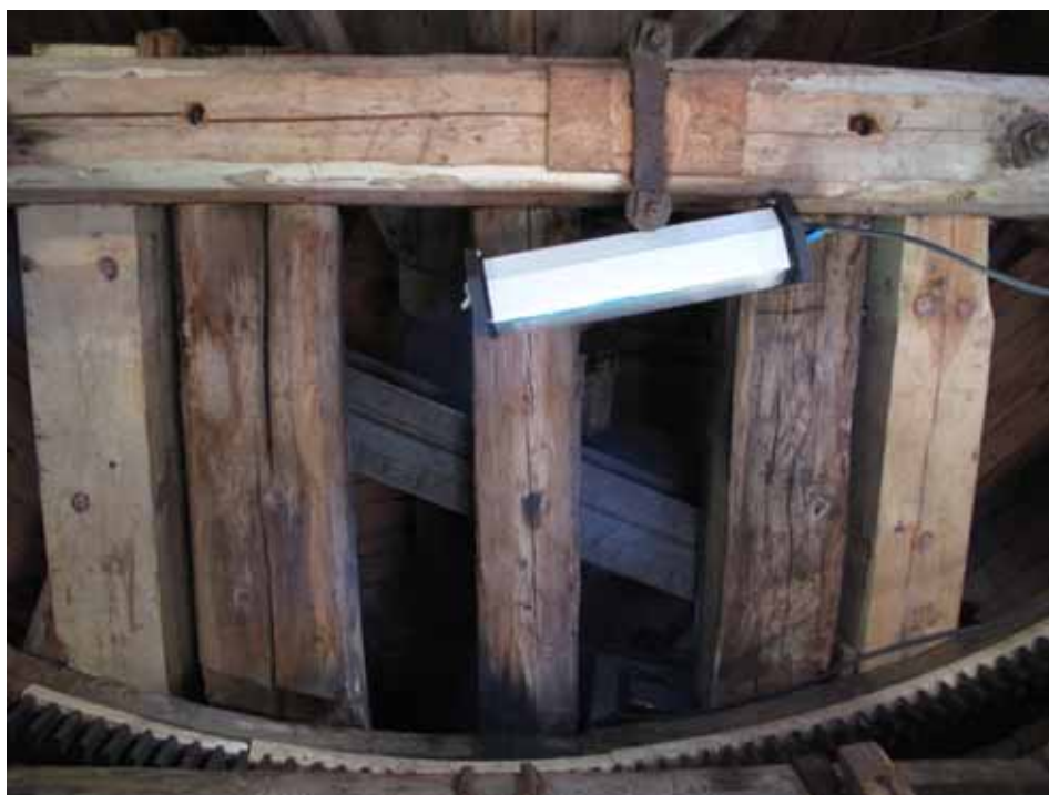
Två nya balkar av furu har ersatt rötskadade balkar. Bildnr: lp20100243
