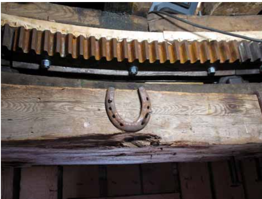
Detalj av nytt kuggsegment och utbytt virke. Bildnr: lp20100242
