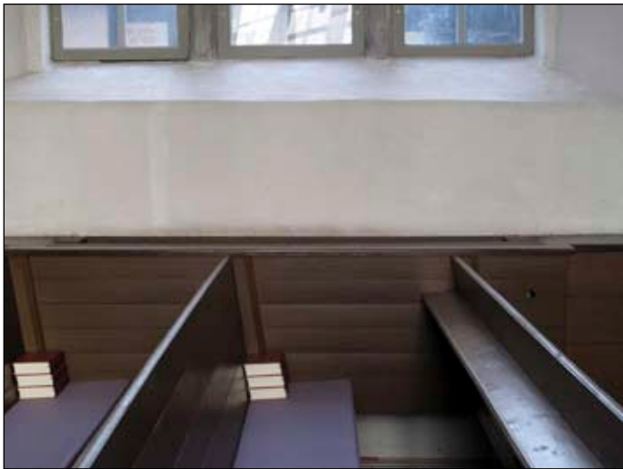
Radiatorer på långhusväggarnas norra och södra sidor placerades som tidigare dolda bakom en bröstningspanel. I öppningen över radiatorerna kompletterades brädningen och målades brun. Foto L. Sundström, bildnr 20111263.
