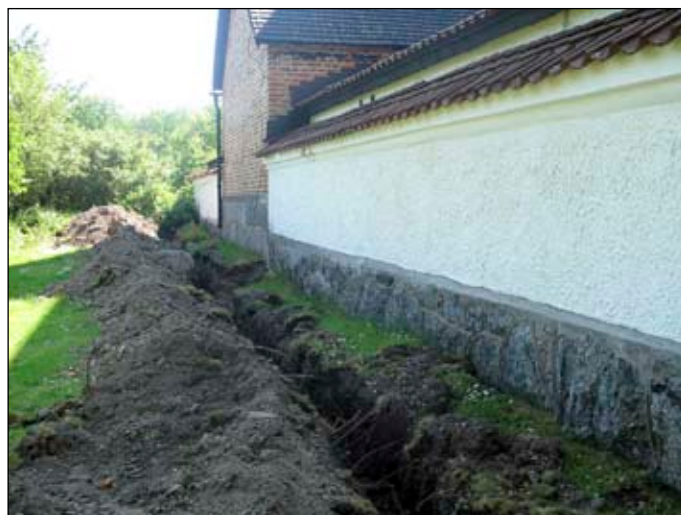
Grävning för dragning av ledningar norr om kyrkogårdsmuren. Foto L. Sundström, bildnr 20111266.
