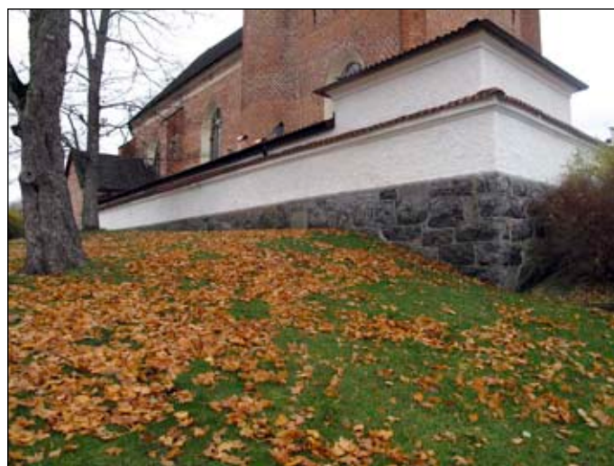
Kyrkogårdsmurens norra sträckning med två nya takhuvar på den innanföriggande ekonomibyggнадen. Foto L. Sundström, bildnr 20111259.
