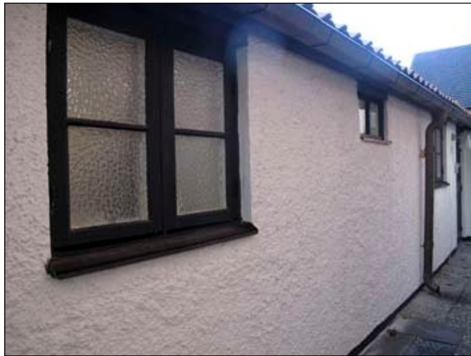
En av ekonomibyggnadens dörrar ersattes av ett mindre fönster och öppningen putsades över. Foto L. Sundström, bildnr 20111265.
