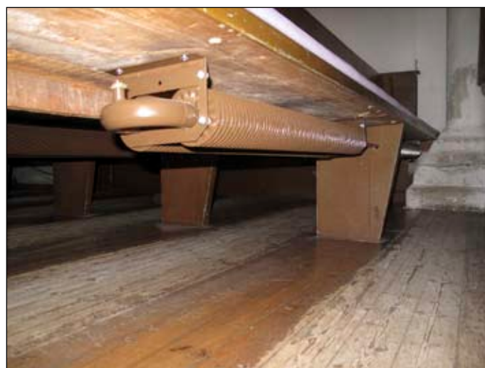
Kamflänsradiatorer placerades under bänkarna och målades in bruna. Foto L. Sundström, bildnr 20111262.
