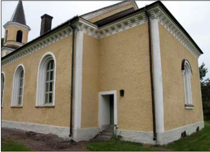
Sakristians södra fasad innan installationen. Foto Albin Uller Lp20111292.
