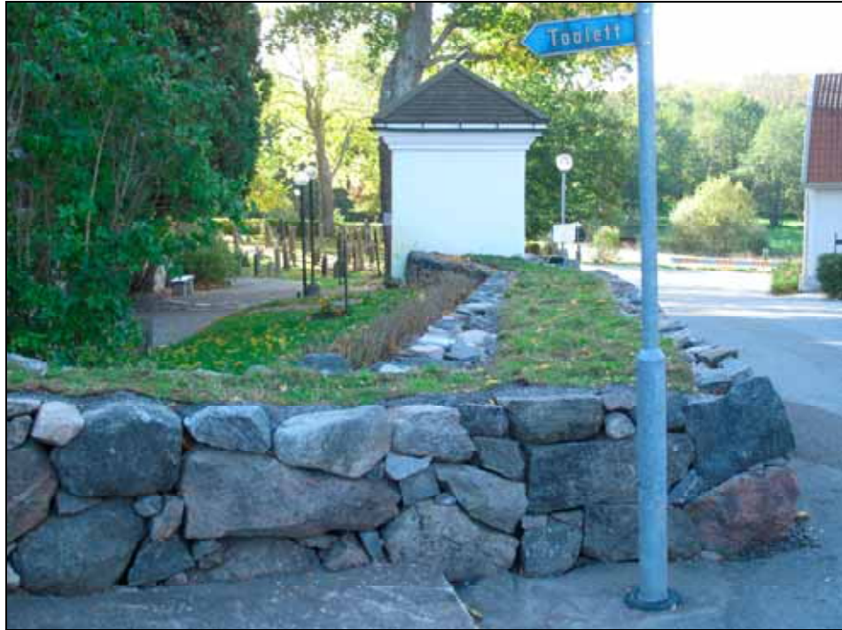
Delsträckan i västra muren norr om stigluckan efter omläggning och täckning med sedummatta.
