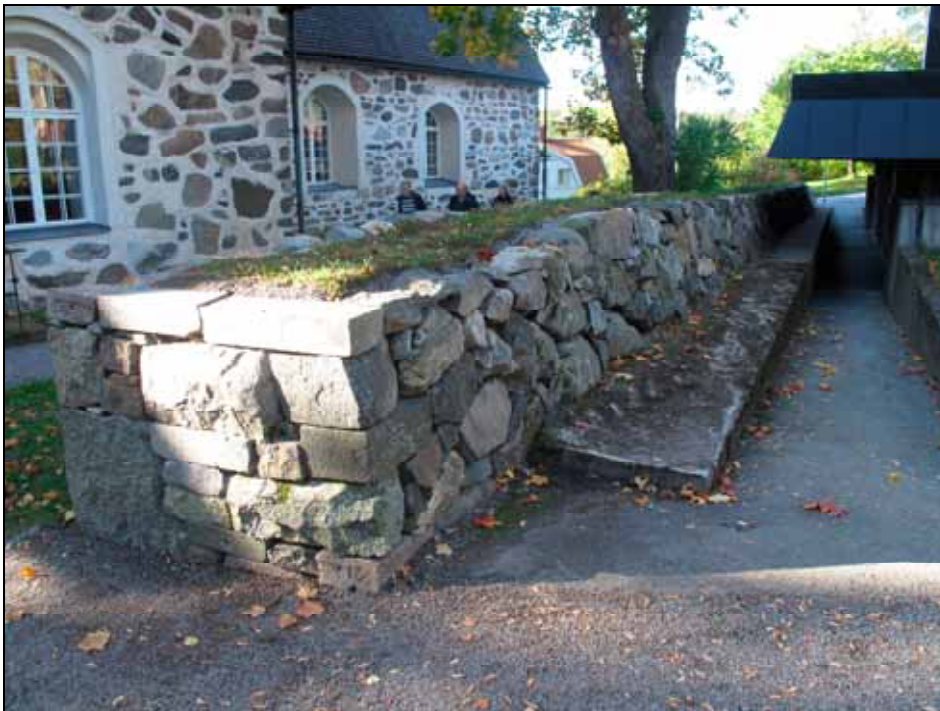
Öppningen efter omläggning.
