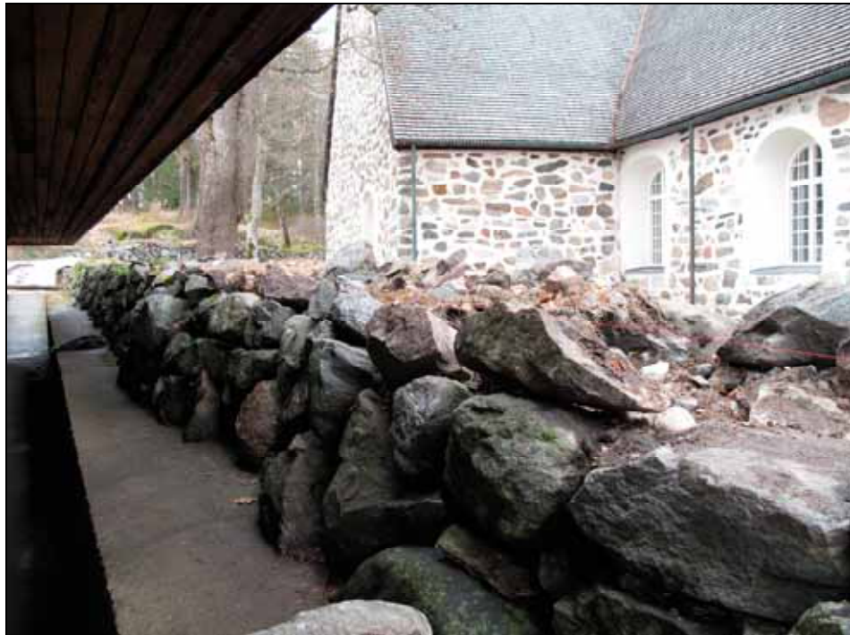
Kyrkogårdsmuren har i nordväst tidigare gjutits fast i de nedre delarna mot ekonomibygnadens gång. Muren har justerats över de fastgjutna stenarna.
