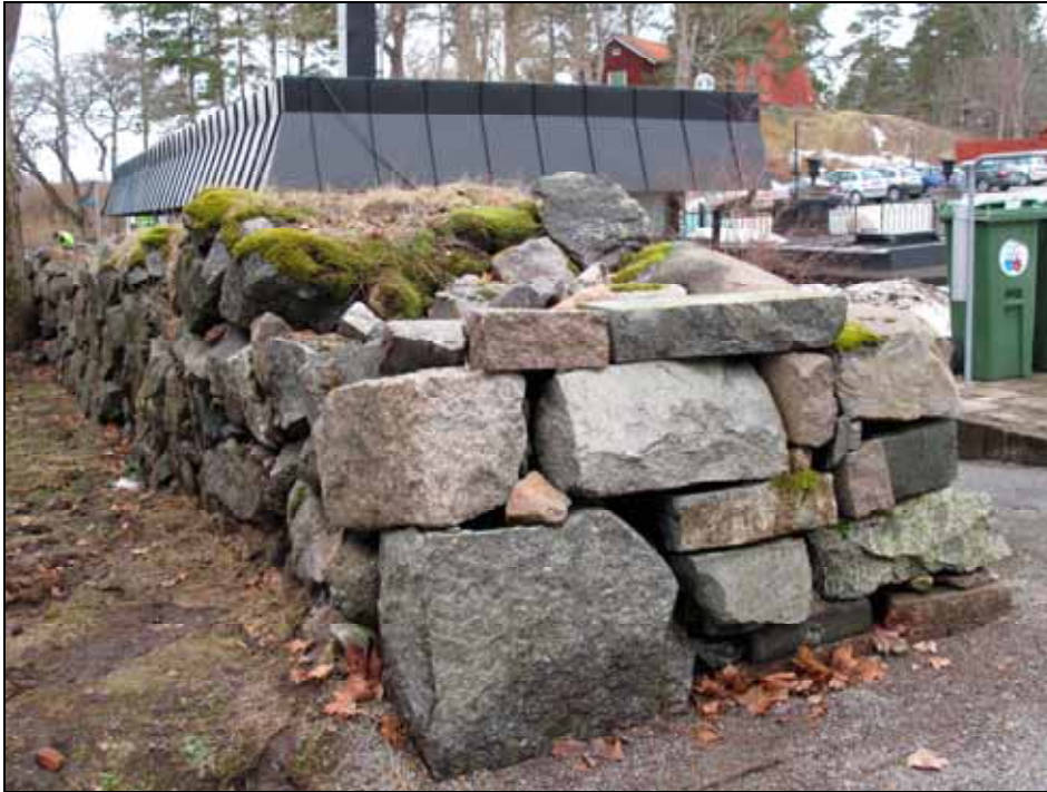
Öppningen i kyrkogårdsmurens nordvästra del var delvis lagd med söndriga gravvårdar som återlades. Den kraftiga ojämnheten i muren vid öppningen justerades med kompletterande sten.
