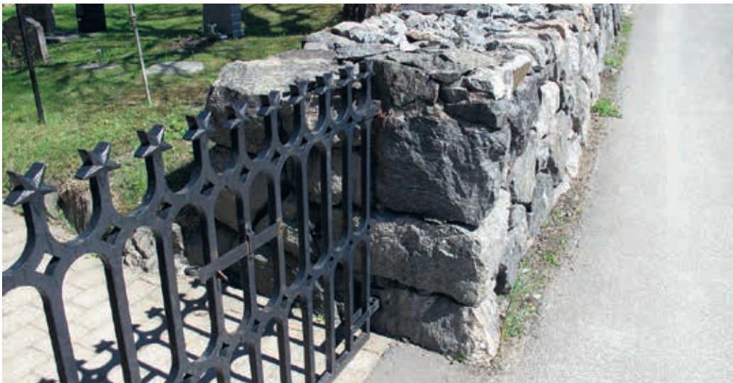
Lp201300426. Delsträcka H-I med murens västra avslut med grind efter omläggning. Foto Albin Uller 2013.
