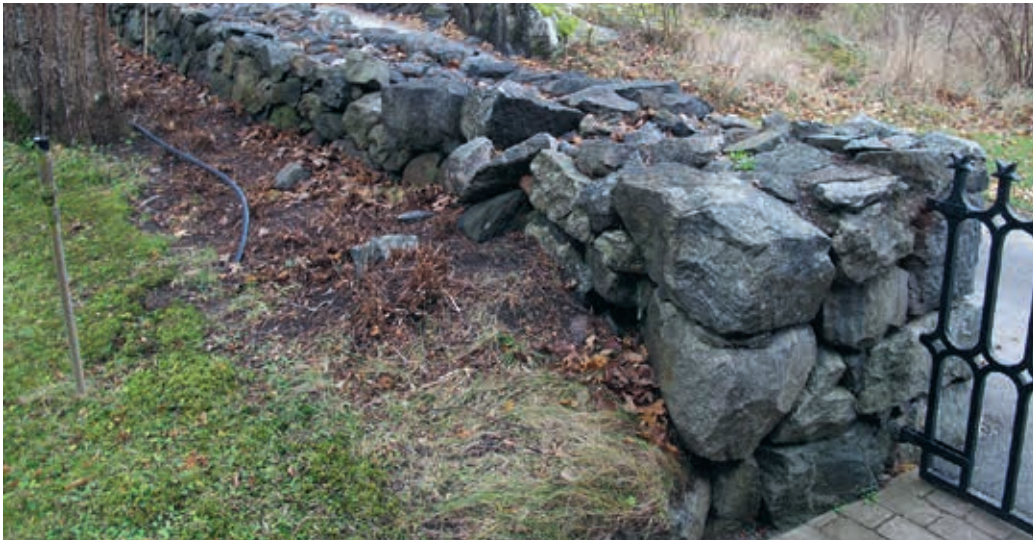
Lp201300411. Delsträcka H-I med murens västra avslut med grind innan omläggning. Foto Albin Uller 2012.
