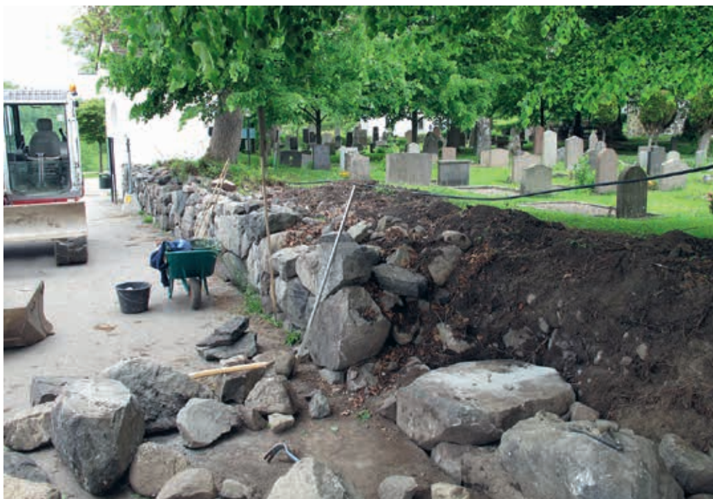
Lp201300455. Delsträcka I-J under omläggning. Här syns jordfyllningen tydligt. Foto Albin Uller 2013.
