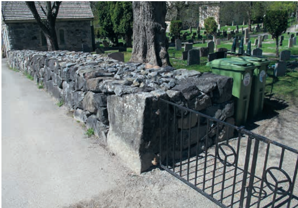
Lp201300430. Delsträcka H-I med murens östra avslut med grind efter omläggning. Här ser man att hörnstenen har lyfts och försetts med nya bärhakar till grinden som satt snett. Foto Albin Uller 2013.
