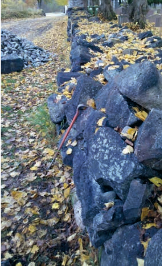
image031. Delsträcka G-H innan omläggning. Bild från entreprenören.
