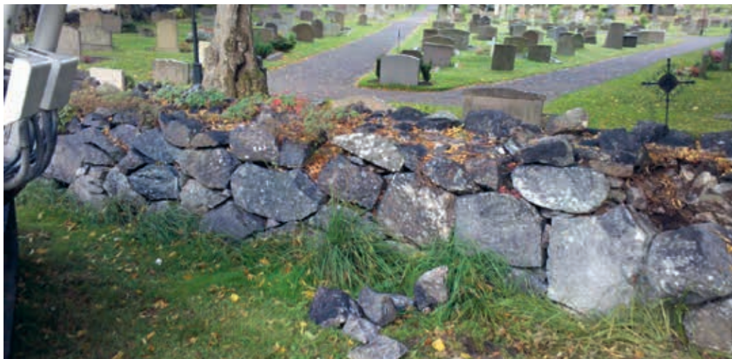
image002. Delsträcka F-G innan omläggning. Bild från entreprenören.
