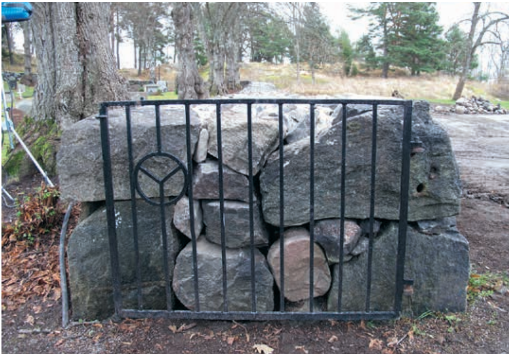
Lp201300388. Delsträcka G-H med murens avslutning med grind efter omläggning. Foto Albin Uller 2012.
