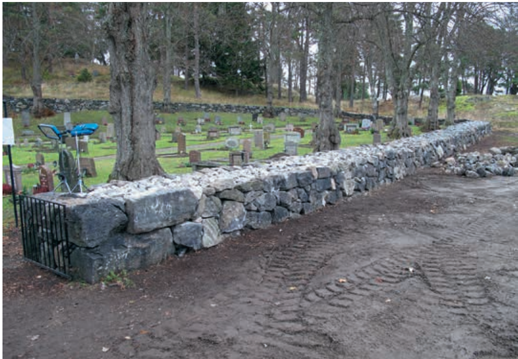
Lp201300383. Delsträcka G-H efter omläggning. Foto Albin Uller 2012.
