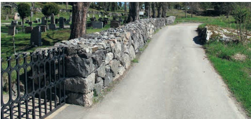
Lp201300425. Delsträcka H-I efter omläggning. Foto Albin Uller 2013.
