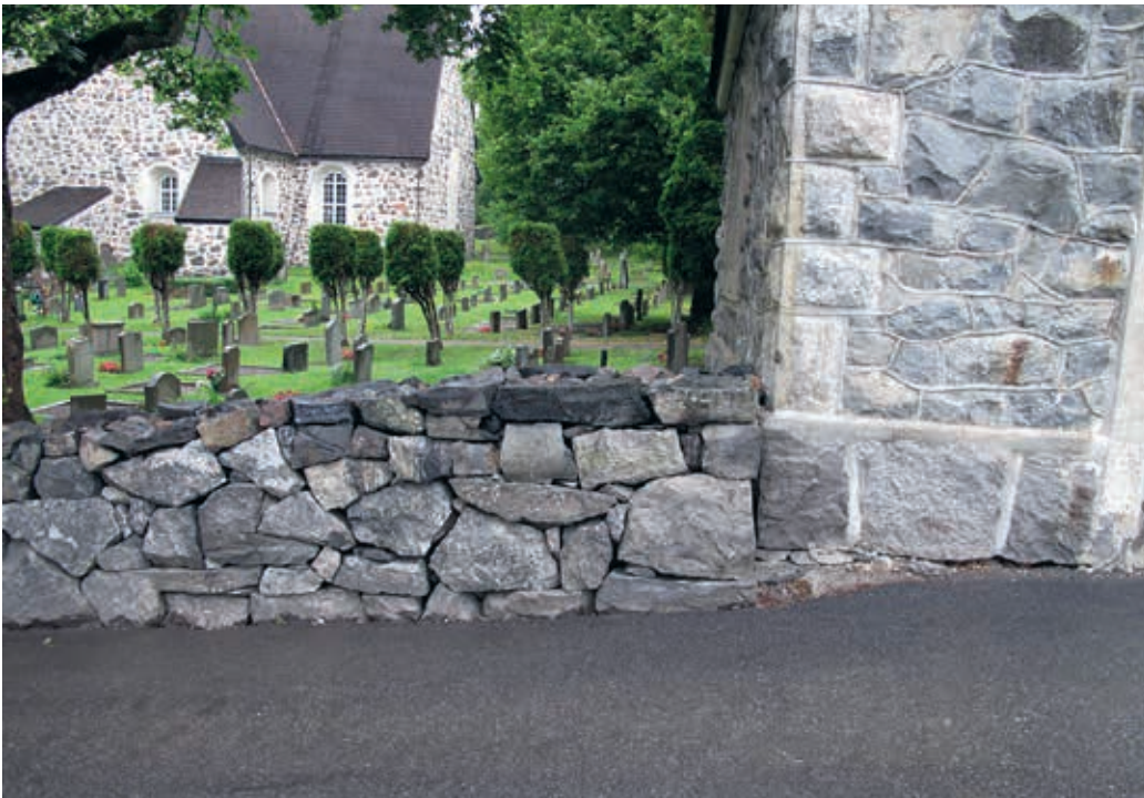
Lp201300460. Delsträcka I-J. Murens anslutning till gravkapellet efter omläggning. Foto Albin Uller 2013.
