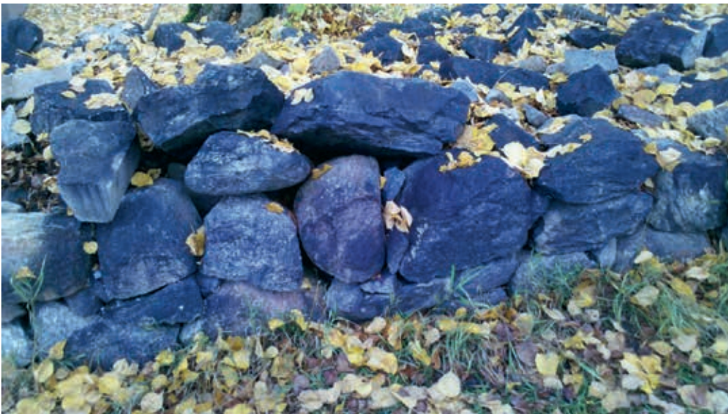
image 032. Delsträcka G-H innan omläggning. Bild från entreprenören.
