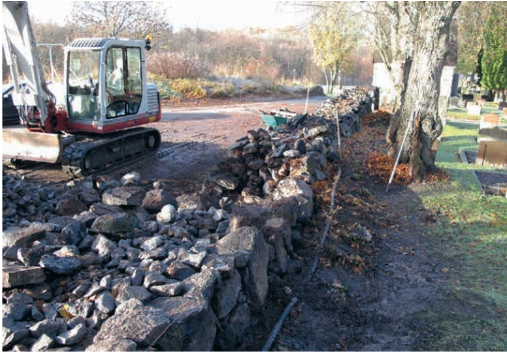
Lp201300370. Delsträcka G-H under omläggning. Foto Albin Uller 2012.
