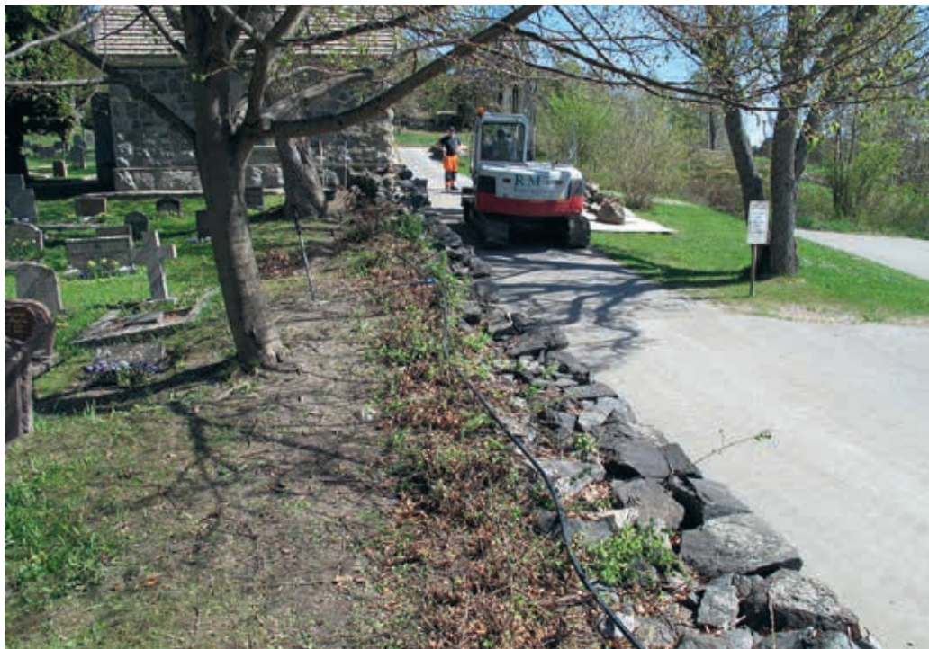
Lp201300444. Delsträcka I-J innan omläggning. Här ser man hur överväxt denna mursträckning var och hur jordfylld den hade blivit. Foto Albin Uller 2013.
