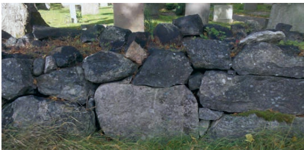
image007. Delsträcka F-G innan omläggning. Bild från entreprenören.
