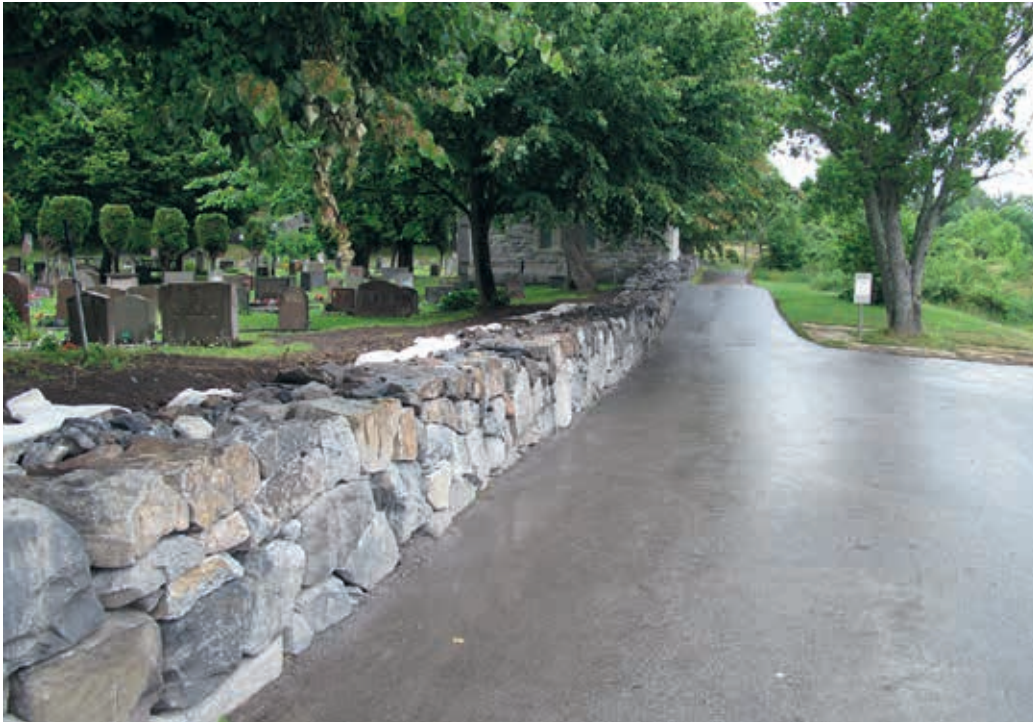
Lp201300471. Delsträcka I-J efter omläggning. Foto Albin Uller 2013.
