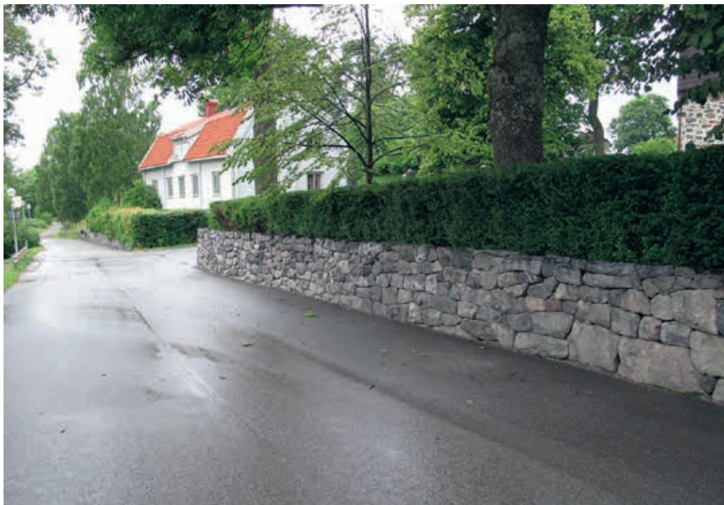
Lp201300474. Bogårdsmurens sträckning efter justering av stenar. Foto Albin Uller 2013.
