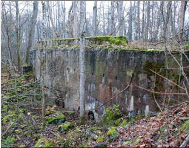
Fig 27. Objekt 3. Rester efter den större byggnaden intill gångbron. Foto: G. Werthwein.
