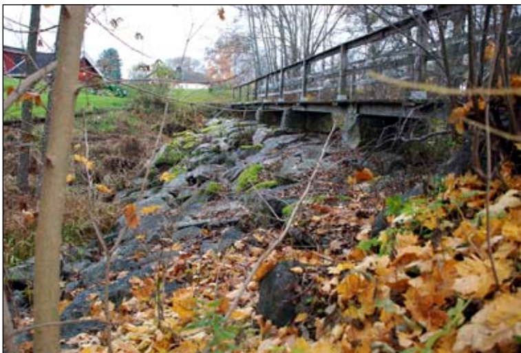
Fig 21. Objekt 2. Det som på 1739 års karta kallas för huvudströmmen är idag igensatt med dels denna stenlagda pir, med gångbro över ån, men även av dammluckor. Denna pir är inritad på 1917 års karta. Foto: G. Werthwein.
