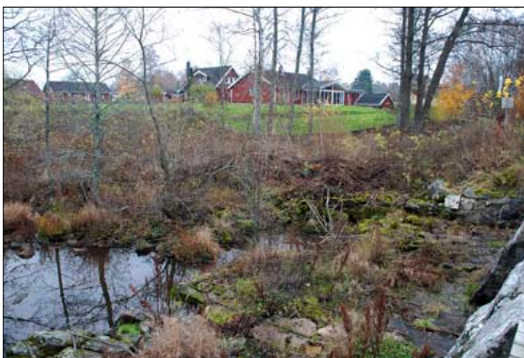
Fig 20. Objekt 1. Kallmurad stenrad som sträckt sig ut i den numer tämligen torrlagda huvudfåran. Foto: C. Petersson.
