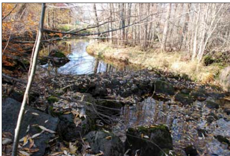
Fig 26. Objekt 2. Fördämning byggd av stenar och cement. Foto: G. Werthwein.
