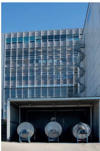
Brygghusets uppglasade södra fasad. Bild nr Idng20130467h. Foto JB.
