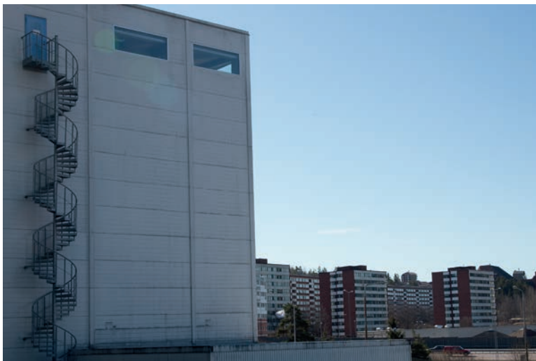
Tankhusets västra fasad med fönster vid taket och utrymningstrappa. Bild nr Idng20130479h. Foto JB.
