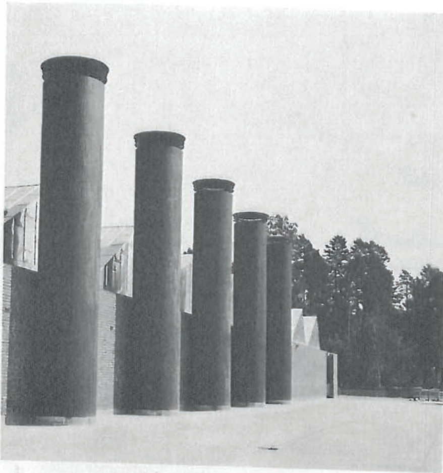
Friskluftindsugning. Betonrør langs værkstedsbygningen. ■ Concrete ventilation shafts along the workshop building.
