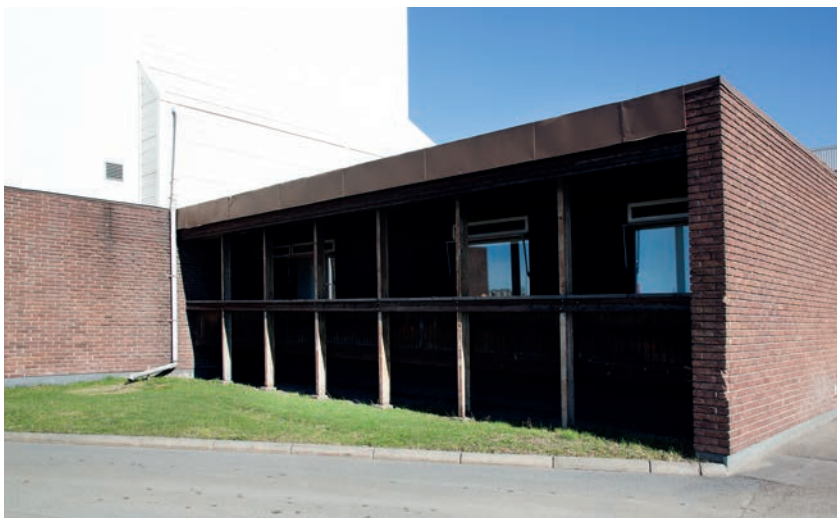
Altanen vid byggnad G som numer är svår att nå. Bild nr ldng20130455h. Foto JB.
