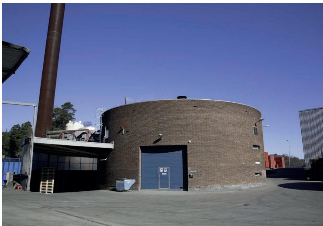
Den cirkelformade panncentralen med nedfartsramp under tak. Bild nr Idng20130487h. Foto JB.
