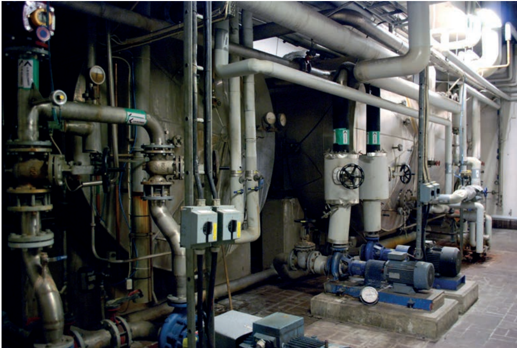
I bryggeriets källare finns fyra varmvattenreservoarer som rymmer 210 m 3 tillsammans och allt varmvatten som behövs i bryggeriet tas härifrån. En stor del av varmvattnet bildas vid vörtkylningen och pumpas sedan in i reservoarerna där det håller en temperatur på 60-80 °C. Av säkerhetsskäl är reservoarerna utrustade med dubbla pumpar. Härifrån försörjs hela bryggeriet med varmvatten. På bilden syns tre av vattentankarna. Foto LKU.
