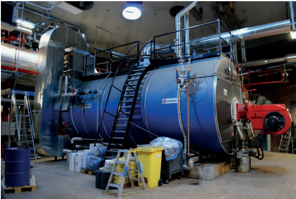
För tillverkning av den ånga som behövs i bryggeriet finns två oljeeldade ångpannor i panncentralen. Här finns också en värmepanna. Ånga används vid exempelvis vörtkokningen, sköljmaskinerna och uppvärmning av cipanläggningarna. Ångan kan även användas för uppvärmning av hetvattensystemet som används till uppvärmning av lokalerna. Bilden visar en av ångpannorna. Foto LKU.
