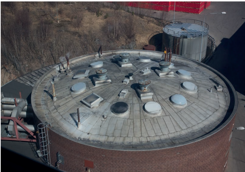
Panncentralens plåtbelagda tak sett uppifrån. Endast ett av de kupoltäckta ljusinsläppen är bevarade. Bild nr ldng20130655h. Foto JB.
