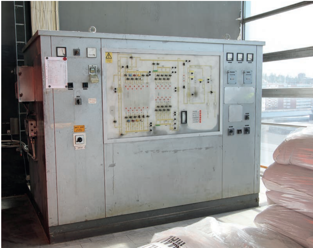
På plan 8 finns malkrossens manuella manöverskåp. På de flesta bryggerier är processen idag datoriserad. Foto HL.
