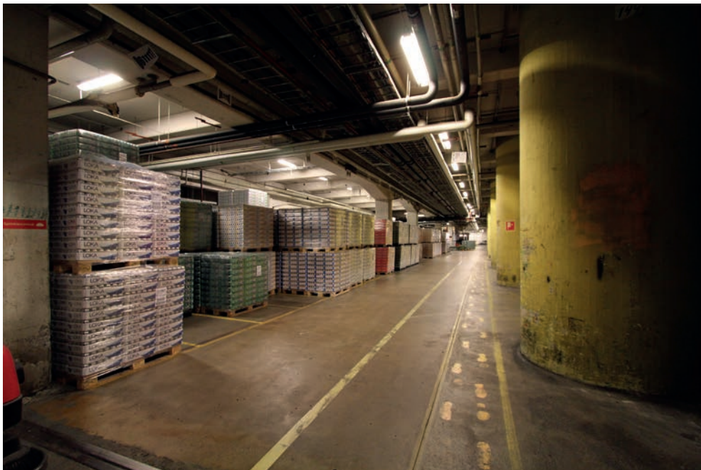
Även det före detta garaget som finns under körgatan mellan "Cigarren" och byggnad C används idag som lager. Längre tillbaka i tiden parkerades lastbilar i garaget under natten. De kraftiga pelare som syns till höger i bild är de friskluftsintag som finns ovan mark utanför "Cigarren". Foto HL.
