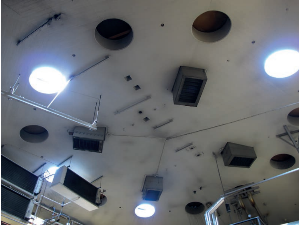
Det brädgjutna välvda betongtaket med runda ljusinsläpp. Bild nr lp201300344. Foto MB.
