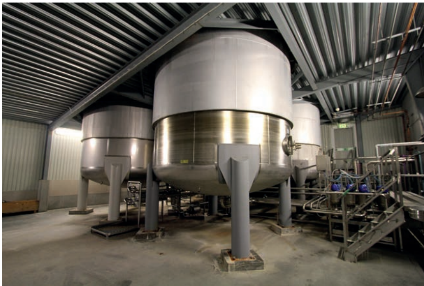
Undersidan av Loka- och cidertankarna. Till vänster i bild syns cidertanken. Foto HL.
