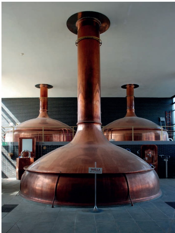
De stora kopparrannorna i bryggsalen är omgärdade av dagsljus som faller in från två håll. Med blänkande ytor av koppar och en pregnant form utgör de en anslående syn. Rannornas rundade former är inte bara estetiskt tilltalande utan bidrar framförallt till en effektiv kokning. Vörtpannan i bildens mitt togs ur drift 1986. I bakgrunden syns de bågiga silken. Foto LKU.
