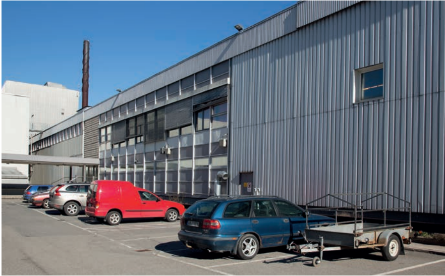
Byggnad C sedd från söder, med byggnad D till höger i bild. Bild nr Idng20130447h. Foto JB.
