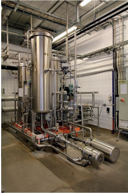
Mixer 4. Den bakre behållaren till vänster innehåller vatten. Till höger om den främre behållaren finns en liten behållare av glas som innehåller syrup (nästan omöjlig att se bakom rören). Bakom den finns behållaren där syrup och vatten blandas. Blandningen går över till den främre behållaren där kolsyra tillsätts innan den färdiga drycken går vidare till kopplingspanelen och tappen via det främre röret som vi ser närmast golvet. Foto HL.
