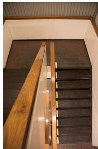
Trapphuset. Bild nr Idng20130615h. Foto JB.
