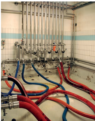
Här kopplas slangar så att det filtrerade ölet kommer vidare till trycktankarna som finns i ett rum rakt ovanför. Miljön med ljus kakel, rostfritt stål och röda, blå och orange slangar är typisk för bryggeriet. Foto LKU.
