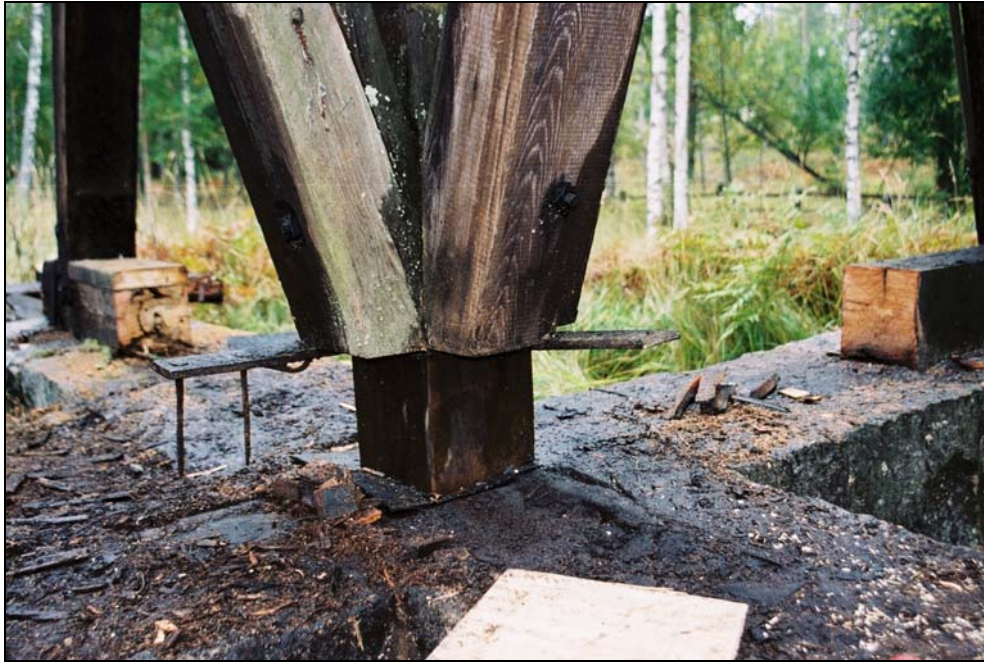
Fig 3. Bildbeteckning: Lp20030127. Ekklossar ställdes i möten mellan högsträvor och syllstockar.
