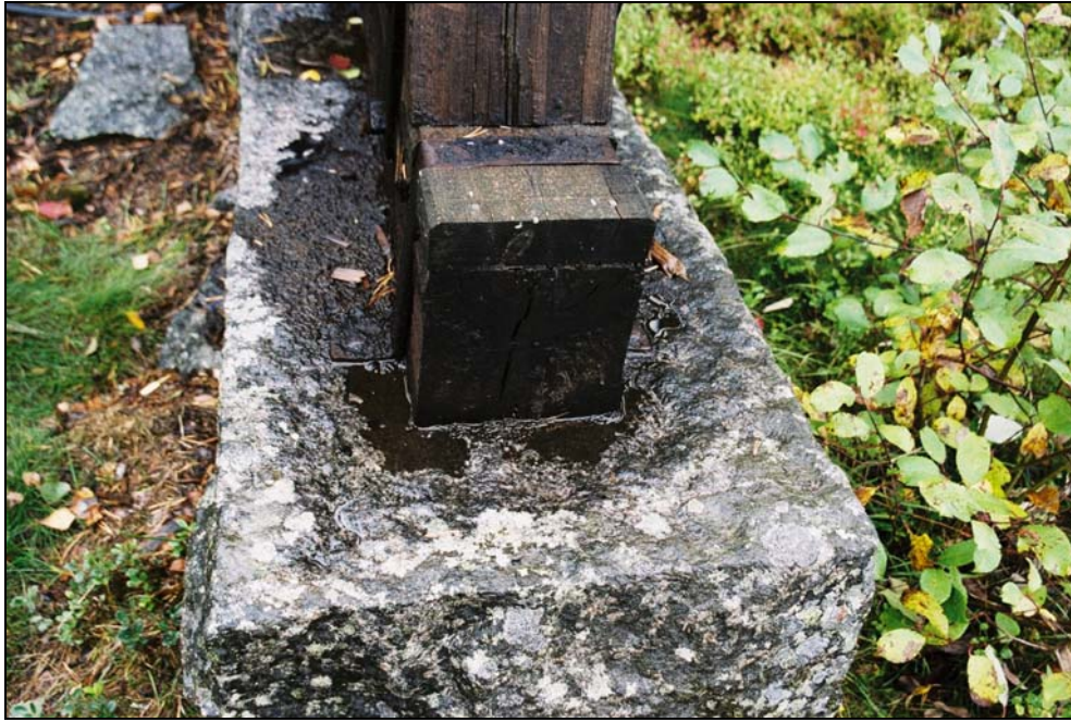
Fig 1. Bildbeteckning: Lp20030128. Stensockel med syll före restaureringen.
