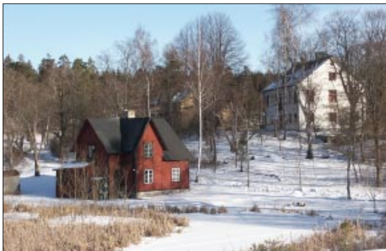
Fig 3. Bildbeteckning: Lp20030001. Vy från söder. Mangårdsbyggnaden och förvaltarvillan uppe på höjden och trädgårdsmästarbostaden på gränsen till det öppna landskapet och ett litet kärr.
