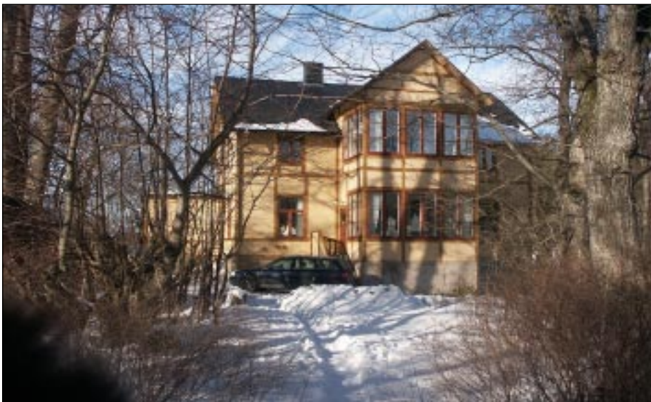
Fig 8. Bildbeteckning: Lp20030003. Förvaltarvillan, uppförd under 1890-talet.
