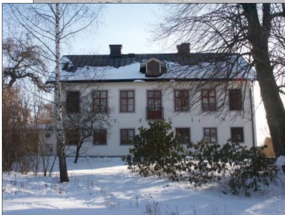
Fig 7. Bildbeteckning: Lp20030004. Mangårdsbyggnaden från väster
