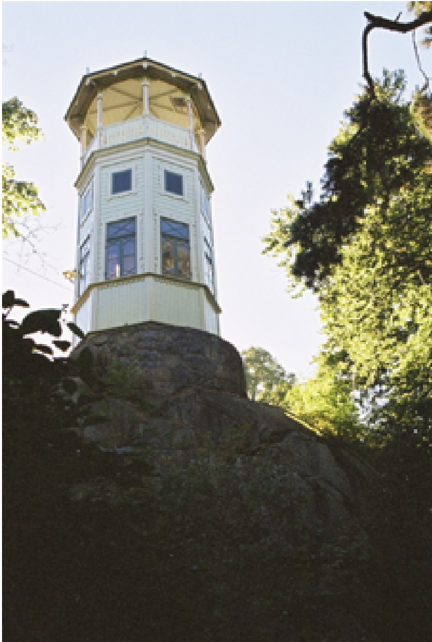
Vattentornet efter restaurering
