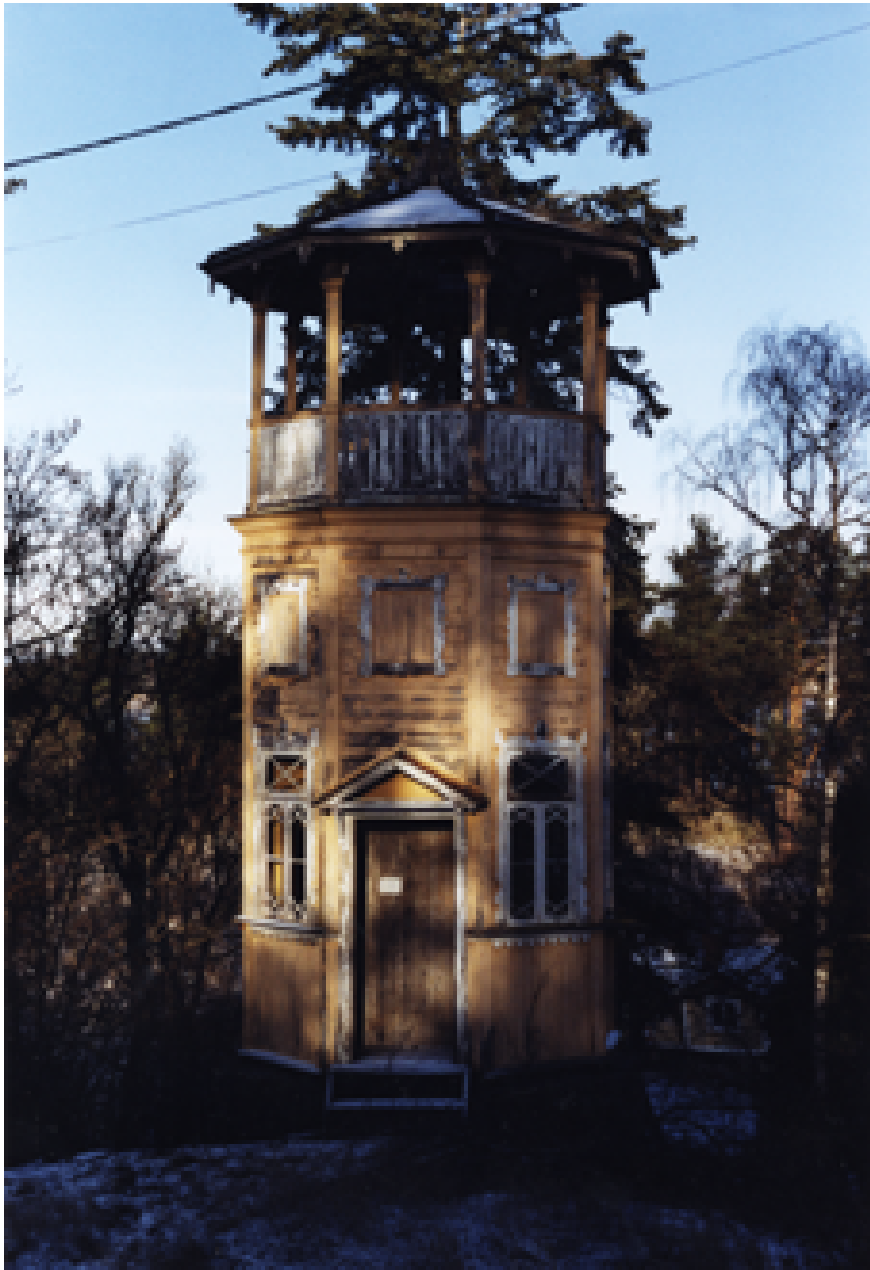
Vattentornet före restaurering. Foto Lisa Sundström, februari 2003.
