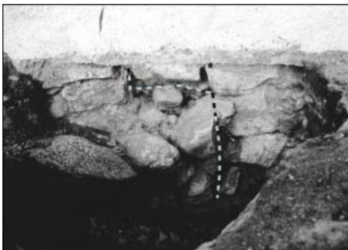
Fig 4. Skarven markerad i grundmuren mellan långhus och kor.
