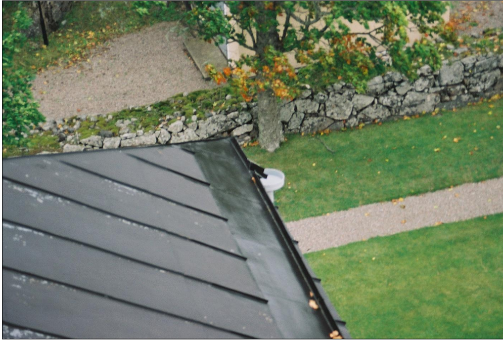
Fotränna och stuprör på Fasterna kyrka. Foto Kersti Lilja
