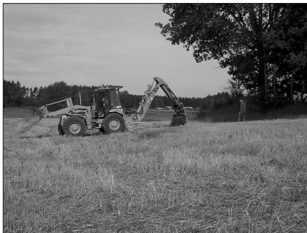
Fig 4. Maskinen i färd med att gräva schakt 5. Foto Göran Werthwein.
