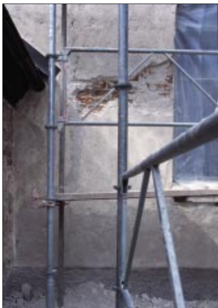
Fig 4. Bildbeteckning: Id20020051b. Igenmurat fönster (förmodat) i långhusets södra fasad nära sakristian. Foto: Elisabeth Boogh.
