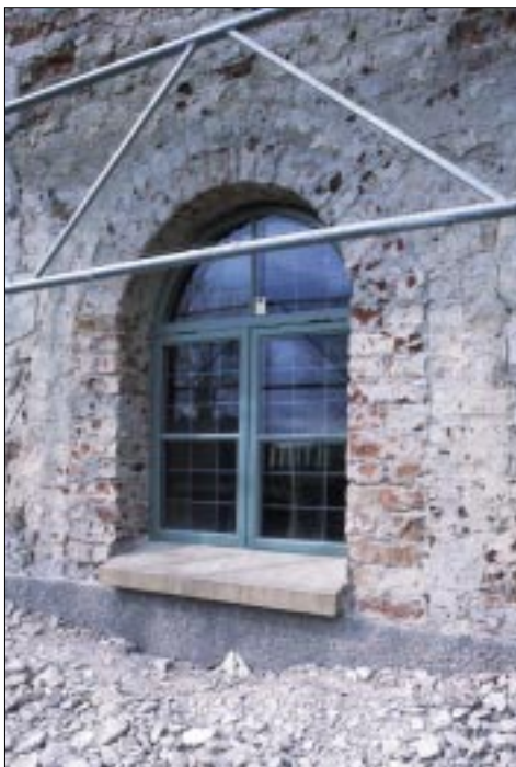
Fig 10. Bildbeteckning: Id20020050b. Fönster med frilagd tegelomfattning i sakristians södra fasad. Observera spåren efter en äldre vapenhusportal runt fönstret. Foto: Elisabeth Boogh.
