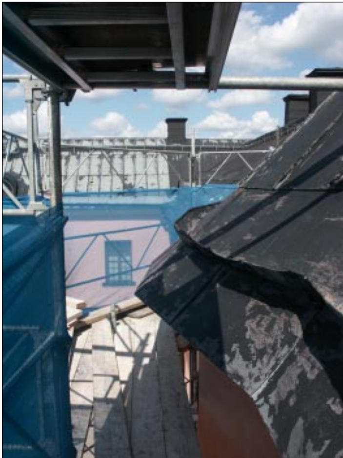
Fig 3. Bildbeteckning: Lp20030109. Plåttak efter rengöring.
