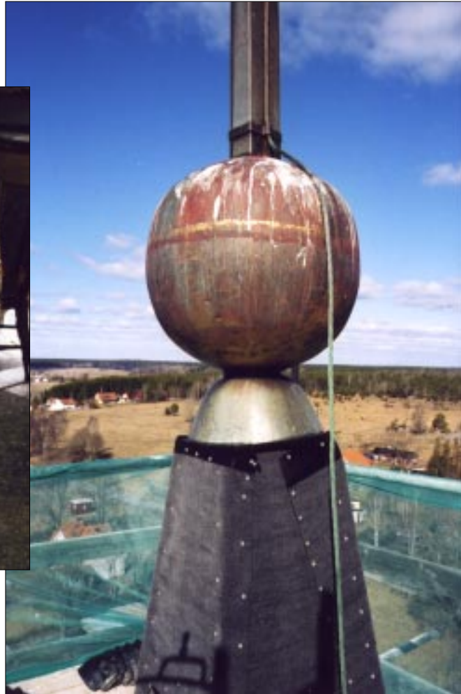
Fig 3. Bildbeteckning: lx20031129b. Tornspirans topp med ny underlagspapp samt kulan före förgyllning.
