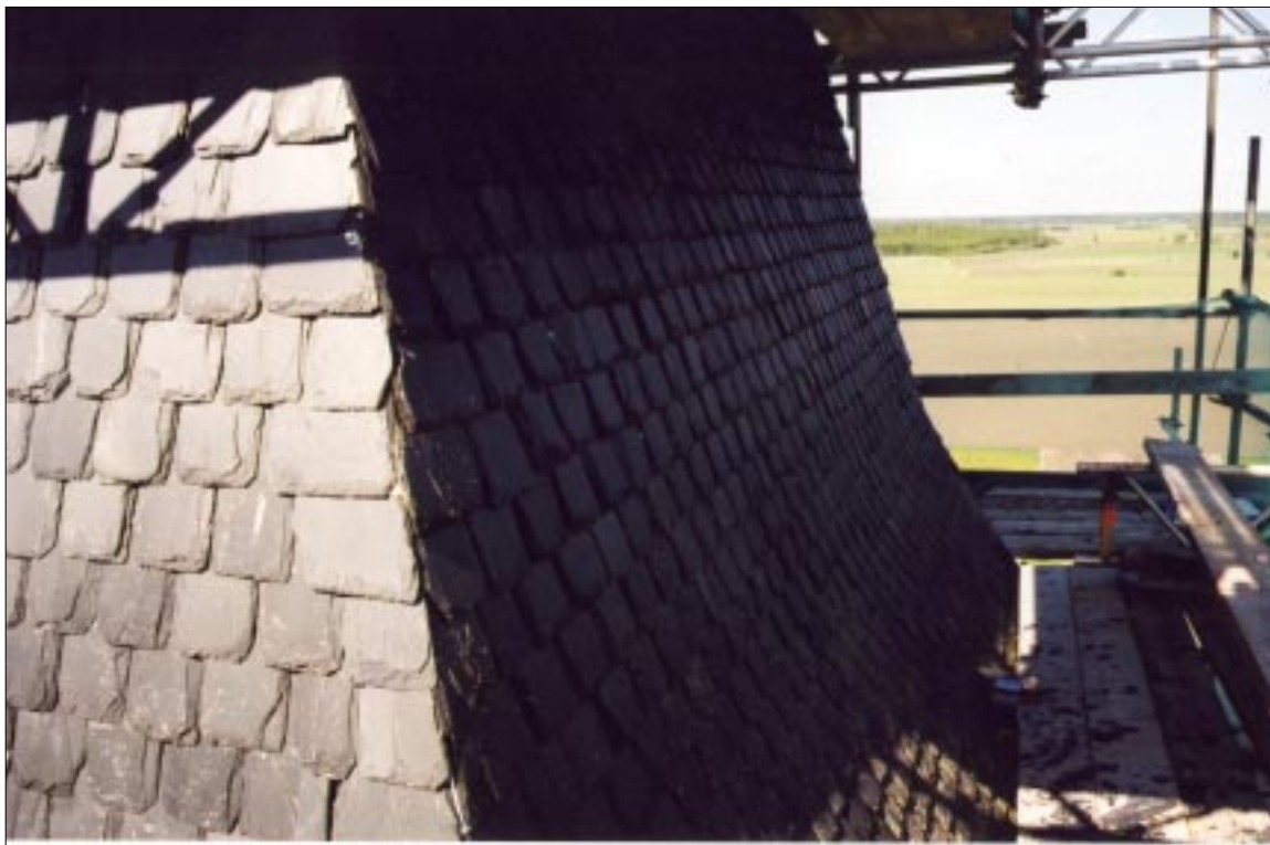
Fig 5. Bildbeteckning: lx20031126b. Torntaket efter omläggningen 2003.
