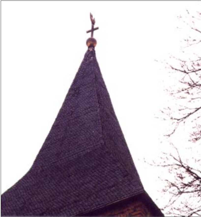
Fig 1. Bildbeteckning: lx20031128b. Tornbuvens skiffertak före omläggning.
