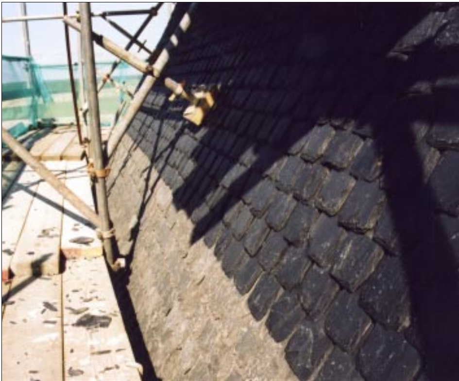
Fig 2. Bildbeteckning: lx20031130b. Skarv mellan äldre och nya skifferplattor från Grythyttan.
