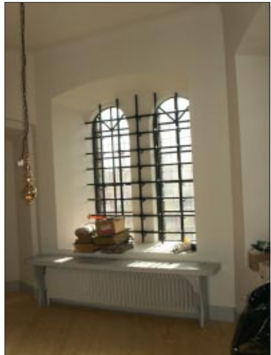
Fig 6. Bildbeteckning: lp 20020021 Fönster i sakristian efter restaureringen.
