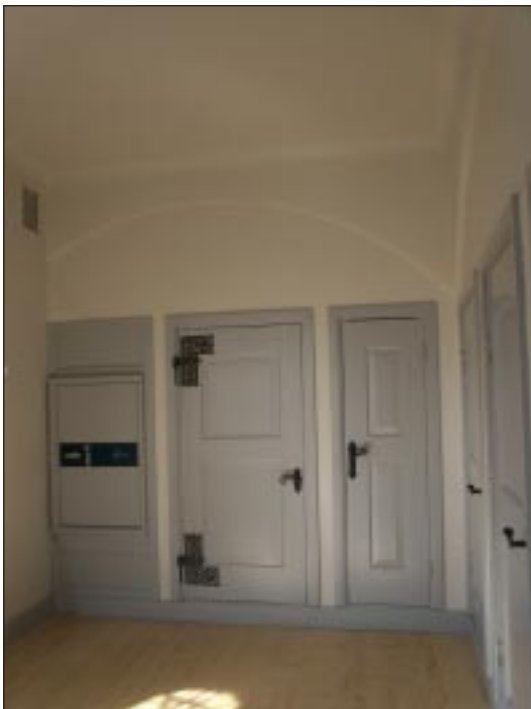
Fig 5. Bildbeteckning: lp 20020020 Sakristian efter restaureringen.
