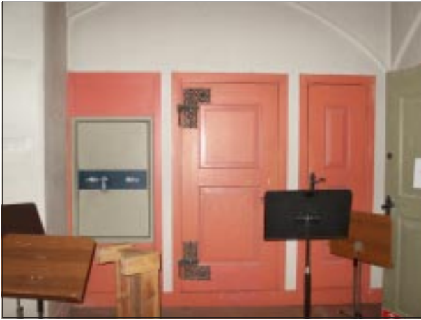
Fig 2. Bildbeteckning: lp 20020015. Snickeriernas färgsättning före restaureringen.
