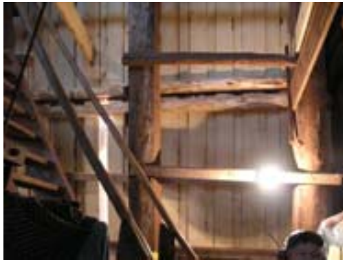
Södra fasadens indida med ny panel och nya reglar. Bildbeteckning: lp20040267. Foto: Kersti Lilja.
