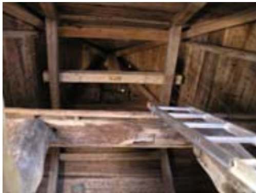
Tornspirans översta konstruktion, vilken korsprydningen är fästad på, efter arbetena. Bildbeteckning: lp20040266. Foto: Kersti Lilja 2004.
