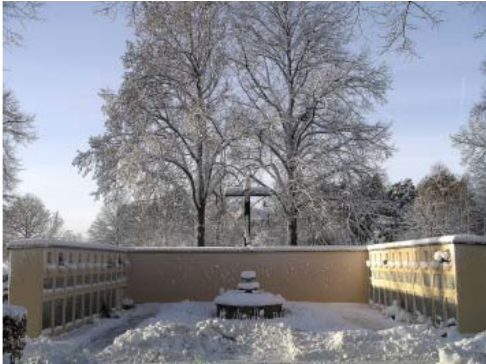
Ip20040271 Kolumbariet efter renovering
