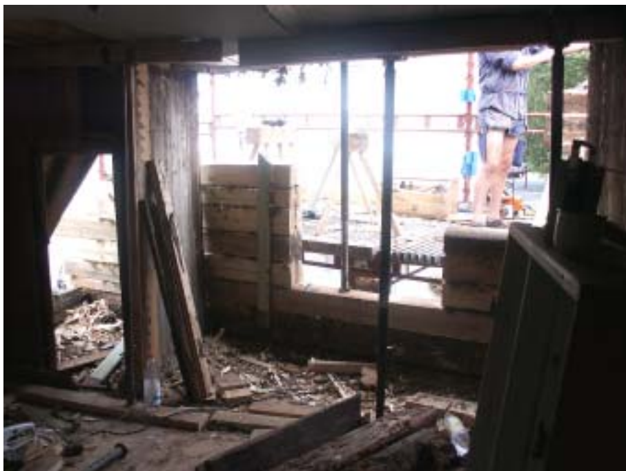
Östra gavelröset sett inifrån. Timmerarbeten pågår. Bild lp20040320.
