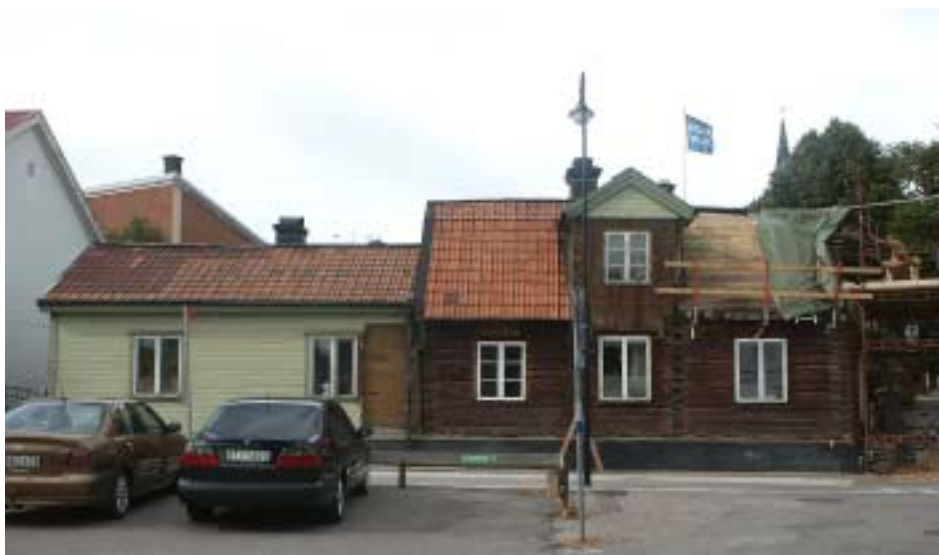
Arbete pågår med timmer arbeten på gaveln. De spröjsade fönstret till vänster visar hur alla fönstren till slut kommer att se ut. Bild lp20040316.
