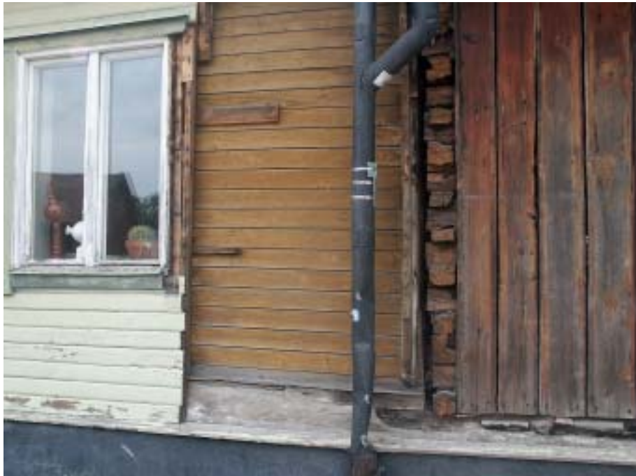
Anslutningen mellan de två byggnaderna som byggdes ihop till en på 1880-talet. Till höger den gamla panelen från omk år 1850, utan sin profilerade locklist. Bild lp2004030324.
