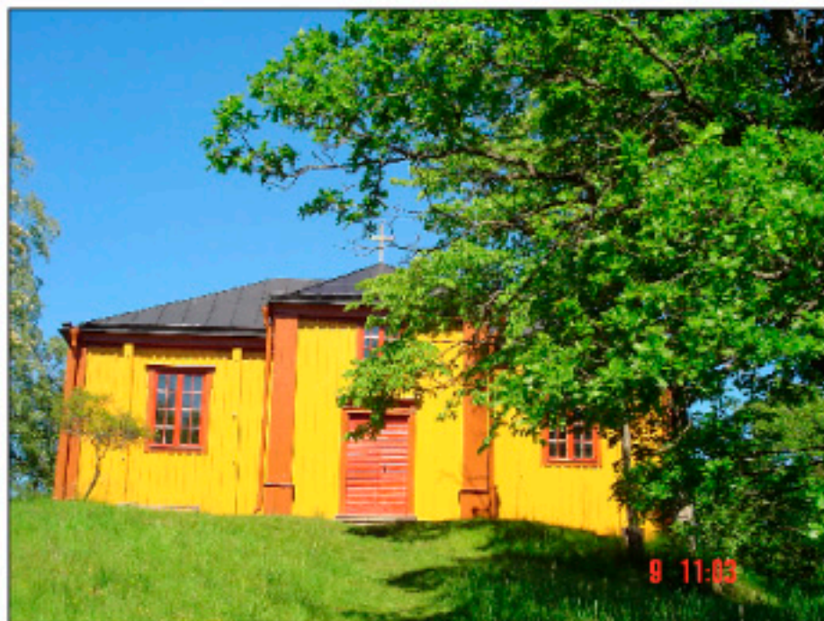
Kapellet efter arbetena, södra fasaden. Foto: Bengt Jacobson, juni 2004.
