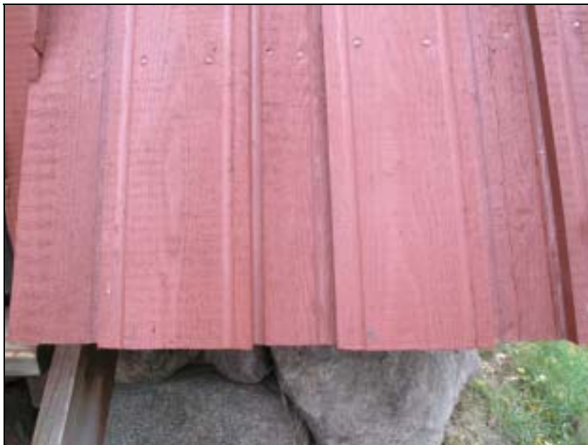
Bildbeteckning: lp20040125. Detaljbild av ny panel med vattrännor på lutande fasadparti. Foto: Kersti Lilja.
