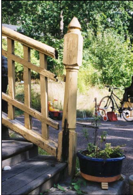
Av stolparna skarvades den ena, den andra var i så dåligt skick av en ny lika befintlig tillverkades. Foto: Lisa Sundström.
