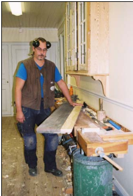
Trappnosar till trappans steg nytillverkades och skarvades. Foto: Lisa Sundström.
