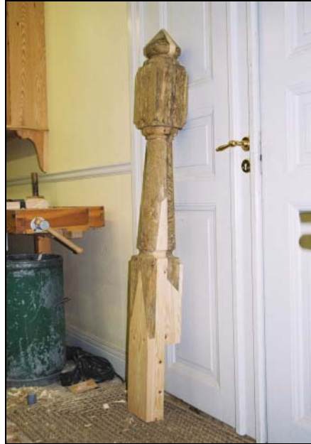
Av stolparna skarvades den ena, den andra var i så dåligt skick av en ny lika befintlig tillverkades. Foto: Lisa Sundström.
