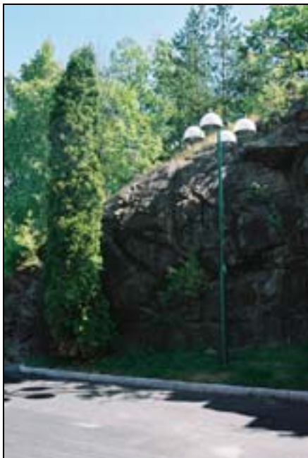
Plantering mot berget med nya kantstöd av granit och ny belysningsarmatur. Foto: Lisa Sundström, juni 2004.
