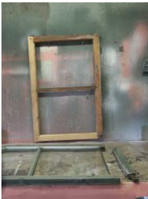
Renovering pågår, bild Lp20020091
