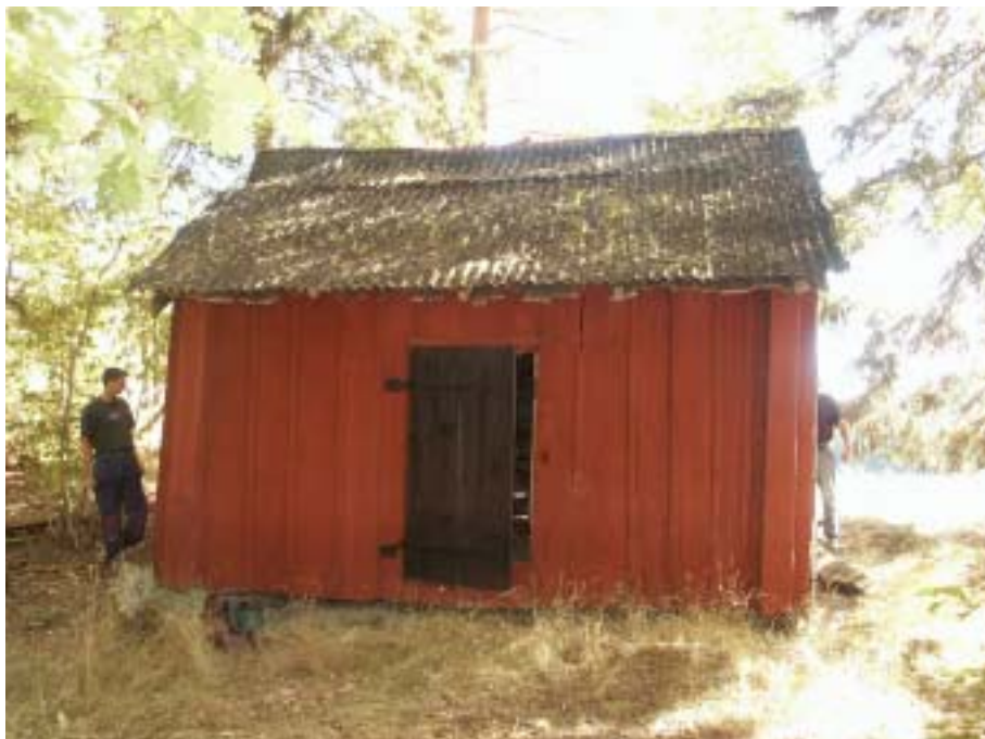
Notboden före renovering. Västsidan med äldre panel bevarad. Bild lp20040308.
