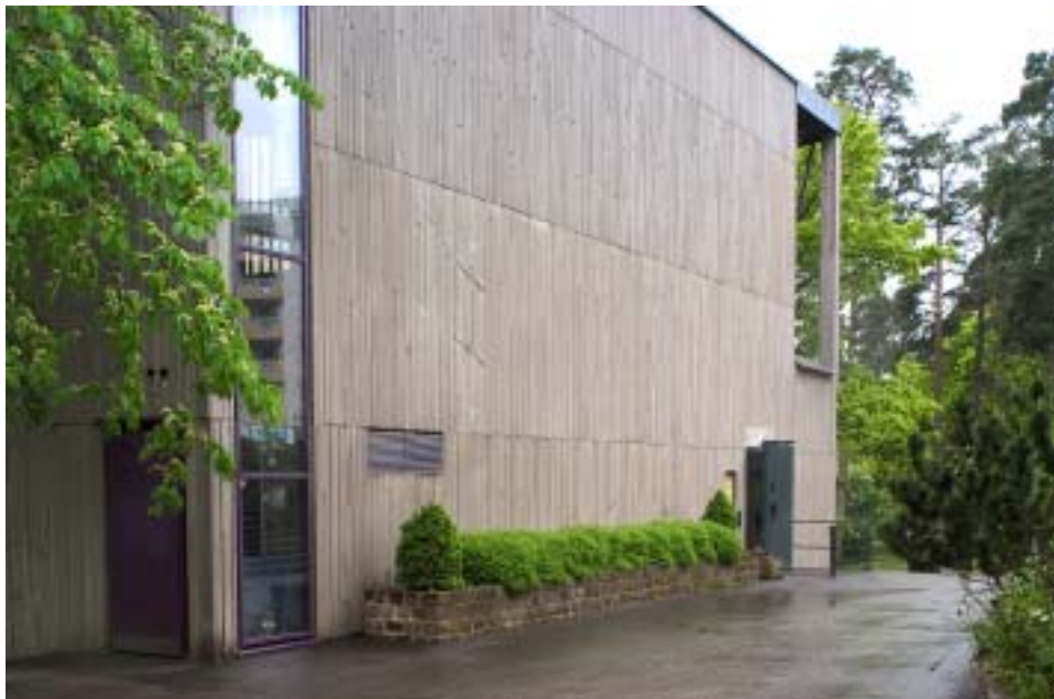
Kyrkan från nordost, entrédörren är utbytt men ännu inte det böga fönsterpartiet och östgavelns utrymningsdörr. Foto Mattias Ek, bild lx20041248b.
