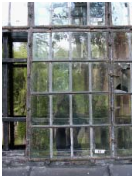
Det äldsta fönstret, längst i söder på östra gaveln före restaurering. Bild lp20050005 och -0007 Foto EW.
