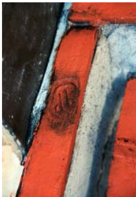
Stämpel på fönstrens järnram, troligen järnbrukets symbol. Stämpeln på bilden sitter på sydvästra fönstergallrets insida, högst upp till vänster (inifrån). Bild lx20050062b.
