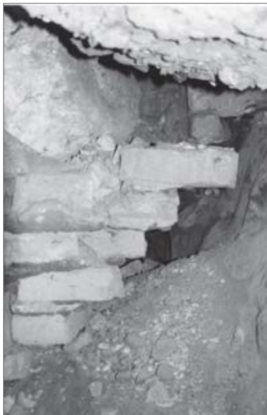
Fig 6. Källartrappan före raset, från väster. Foto Anders Jonsson.
