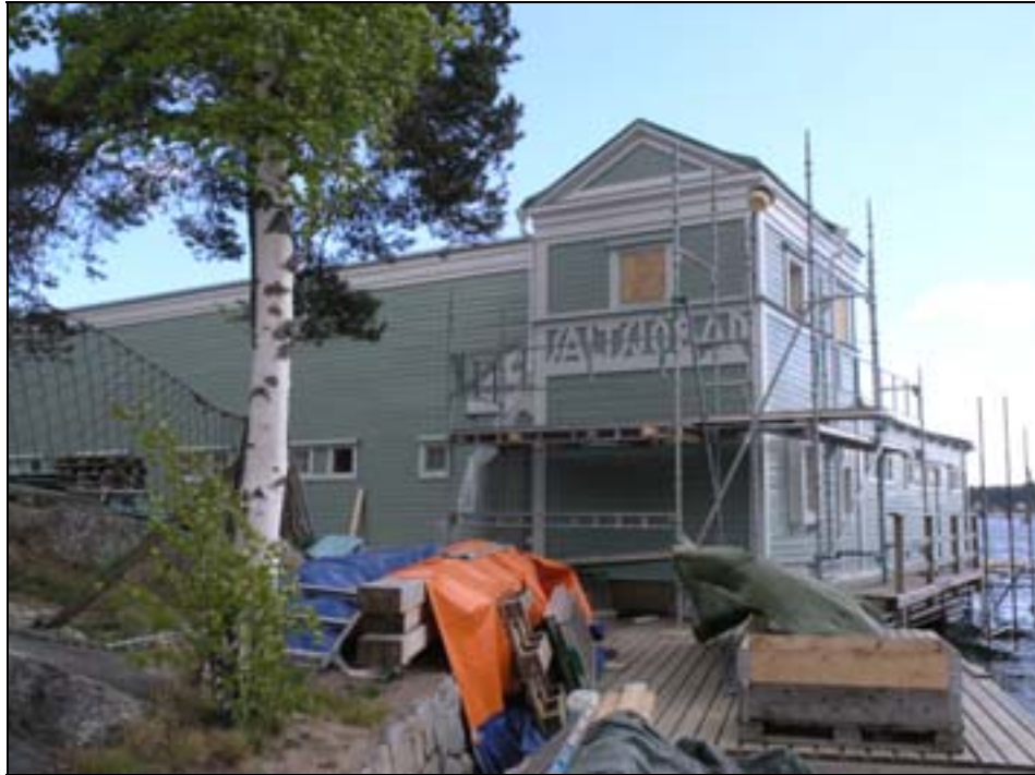
Bildbeteckning: lp20050614. Dambadet efter målningsarbetena. Foto: Kersti Lilja 2005.
