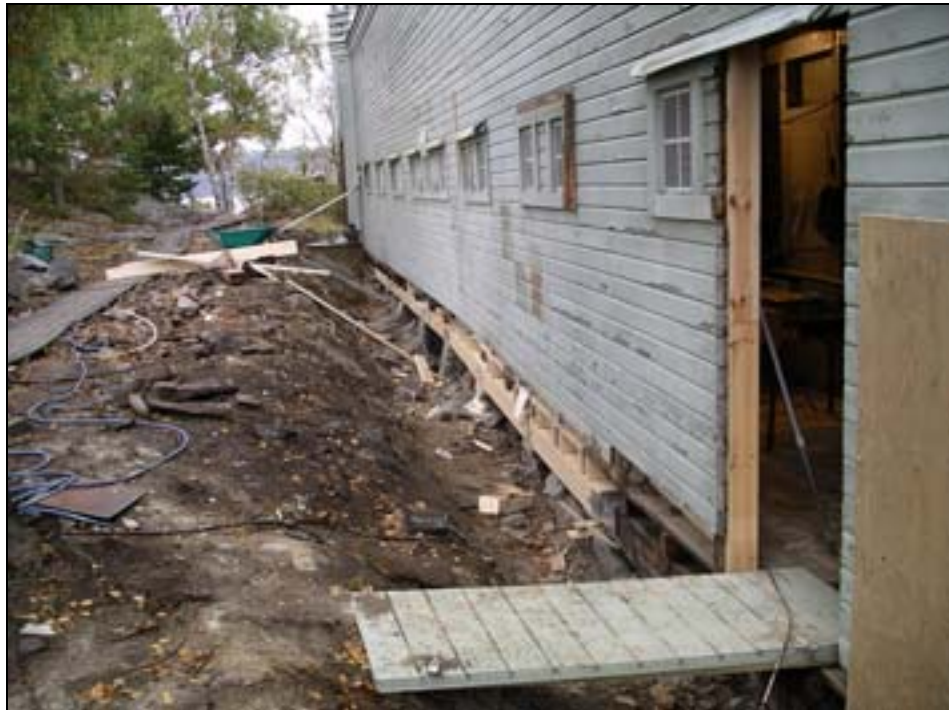
Bildbeteckning: lp20050610. Grundläggningen gjordes om år 2003. Stålstolpar i kombination med limträbalkar möjliggjorde en smäcker konstruktion. Foto: Kersti Lilja oktober 2004.
